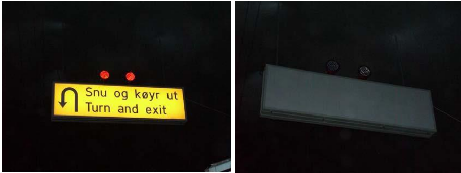
Figur V6.1: Eksempel på skilt og signal for snunisje i tunnel. To-posisjonsskilt vist i aktiv og passiv stilling [24]
