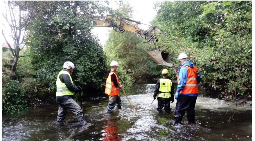
Fra gytegrusutlegg i Åmselva i Nedre Vats. Tiltaket ble planlagt og gjennomført av Vindafjord Jakt- og Fiskerlag, i samarbeid med ivrige grunneiere.
