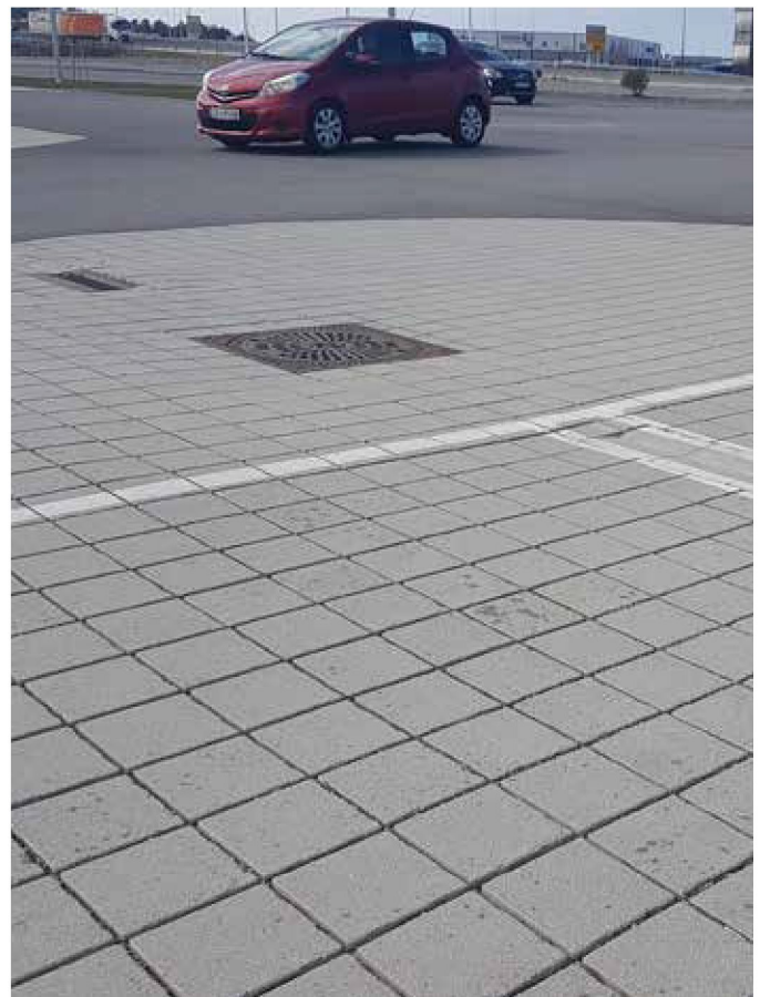
Figur 7-4 Permeabel overflate, parkeringsareal Obs Bygg.
