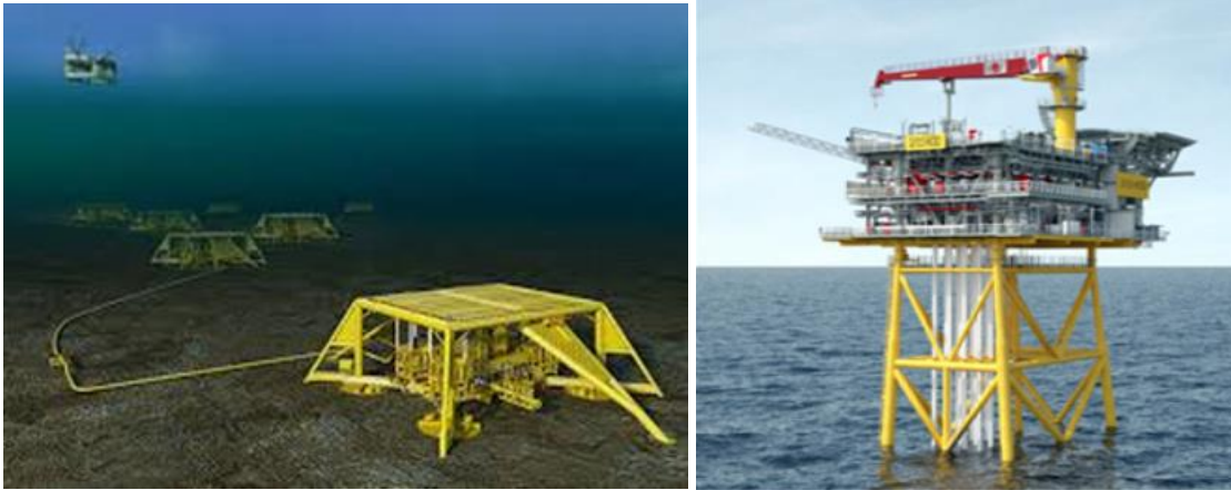
Figur 5. Eksempler på havbunnsanlegg og ubemannet plattform som vil være utbyggingsløsning for de aktuelle funnene.
