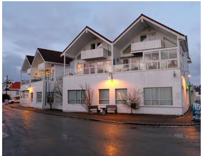
Avkjørselen fra Kanalvegen mot Nessagadå. Hovedvei med opparbeidet fortau og kantsoner med sitteplasser.
