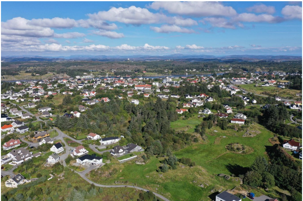
Skoleområdet sett fra sørvest. Ny skolebygning er tenkt plassert midt i bildet, i øvre del av den skogklede dalen. Foto: Karmøy kommune
