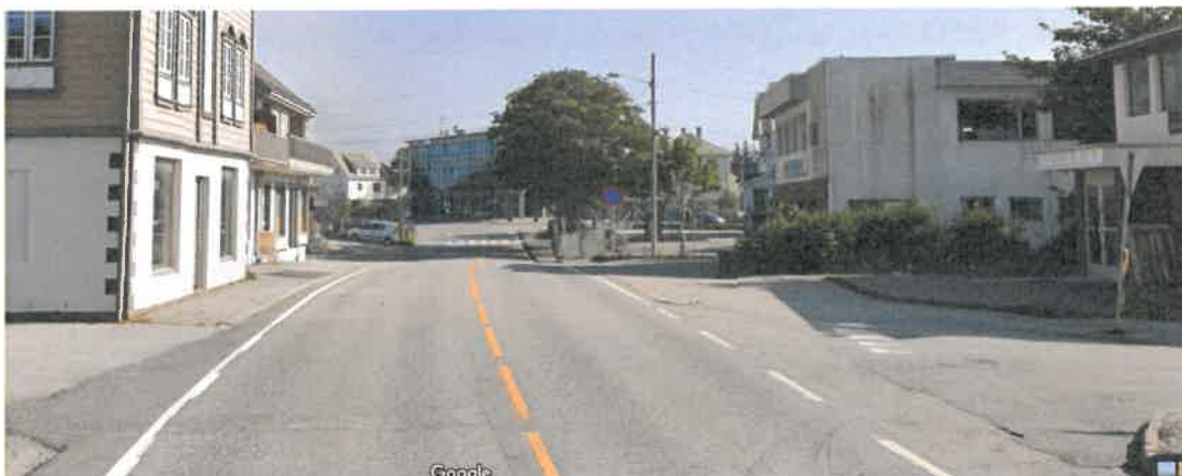
Smale fortau, manglende fortauskant, rygging ut i veg. Bør oppgraderes med gatestruktur.
