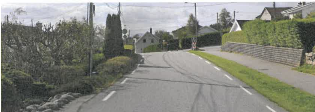
Kryss med Eikjevegen sees lenger fremme. Behov for fortau på østsiden av Skrevegen.
