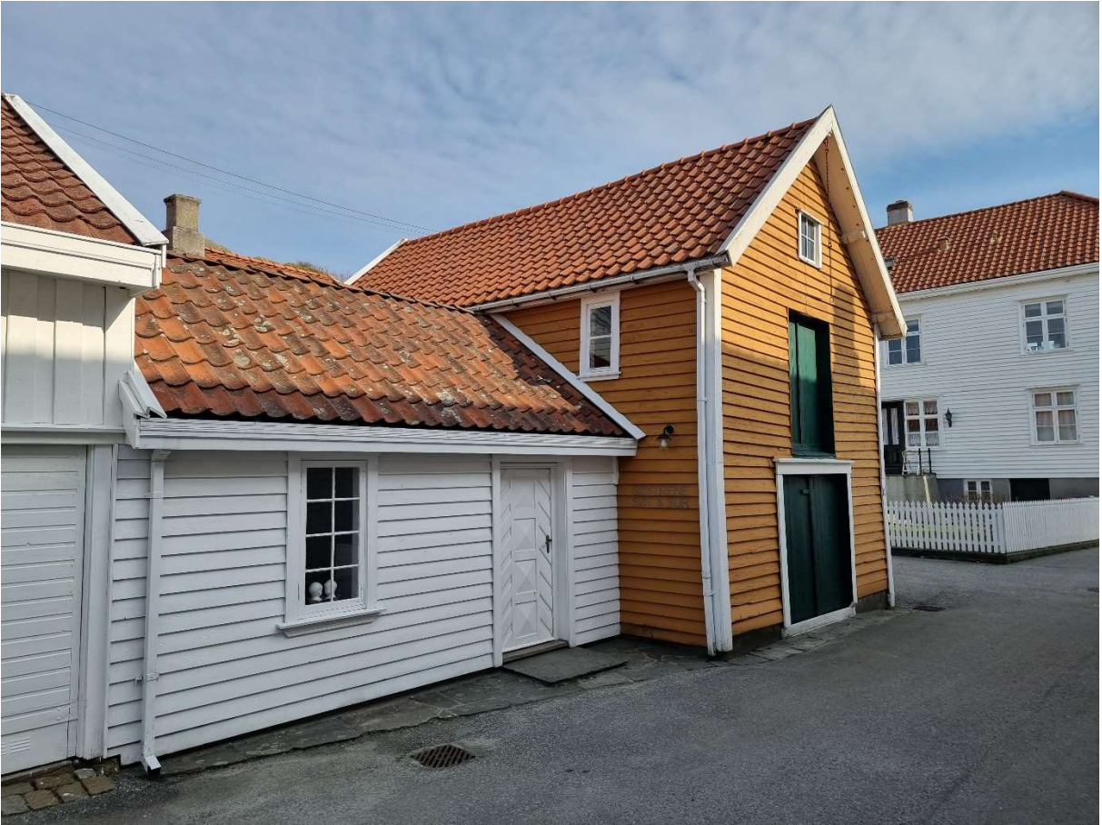
Figur 1. Fasade mot sørvest
