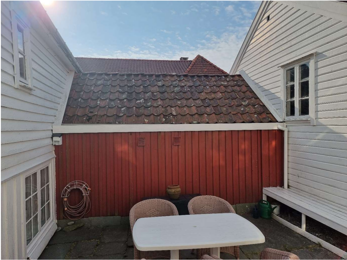
Figur 5. Fasade mot nordøst
