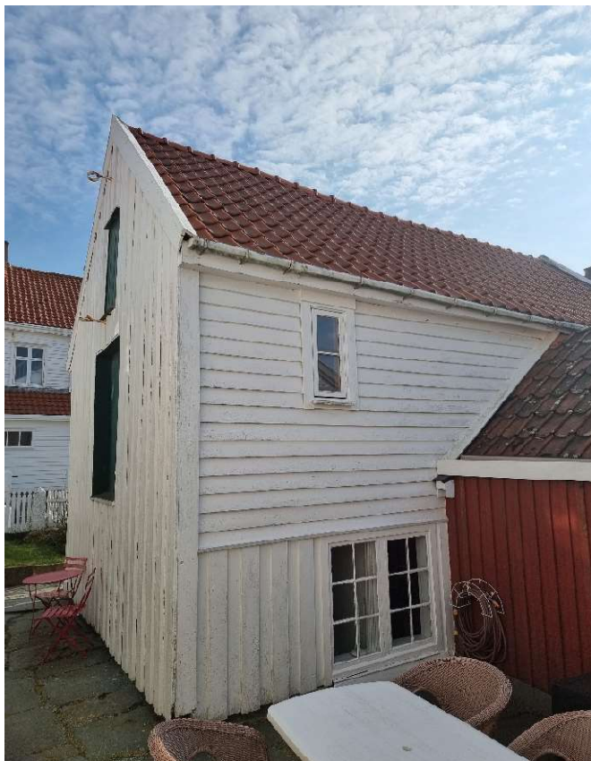
Figur 3. Fassade mot nordøst og nordvest
