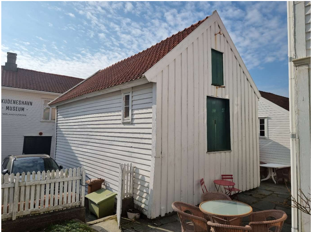
Figur 3. Fassade mot sørøst og nordøst
