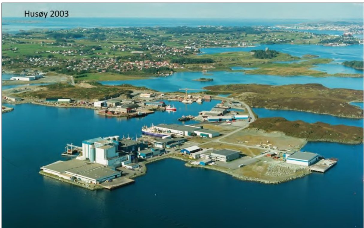
Figur 3 Bildet over viser utbygging av Husøy 2003. Kilde: Karmsund Havn IKS.
