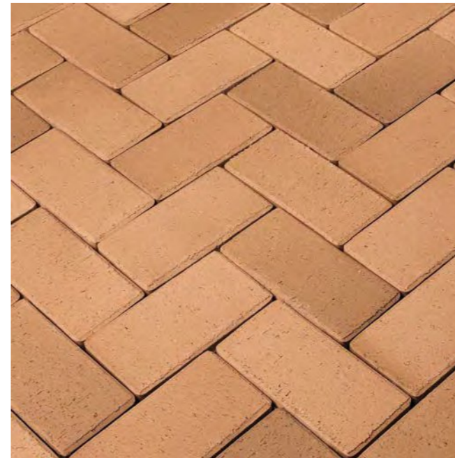
Eksempel på varierende leggeretning i dekke med marktegl. Fra Grønnegade torg i Odense av Masu Planning
