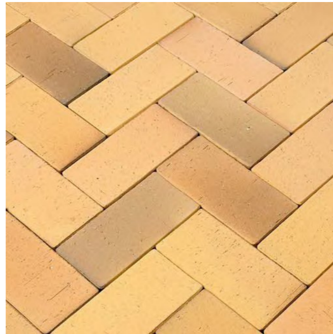
Eksempel på varierende leggeretning i dekke med marktegl. Fra Grønnegade torg i Odense av Masu Planning
