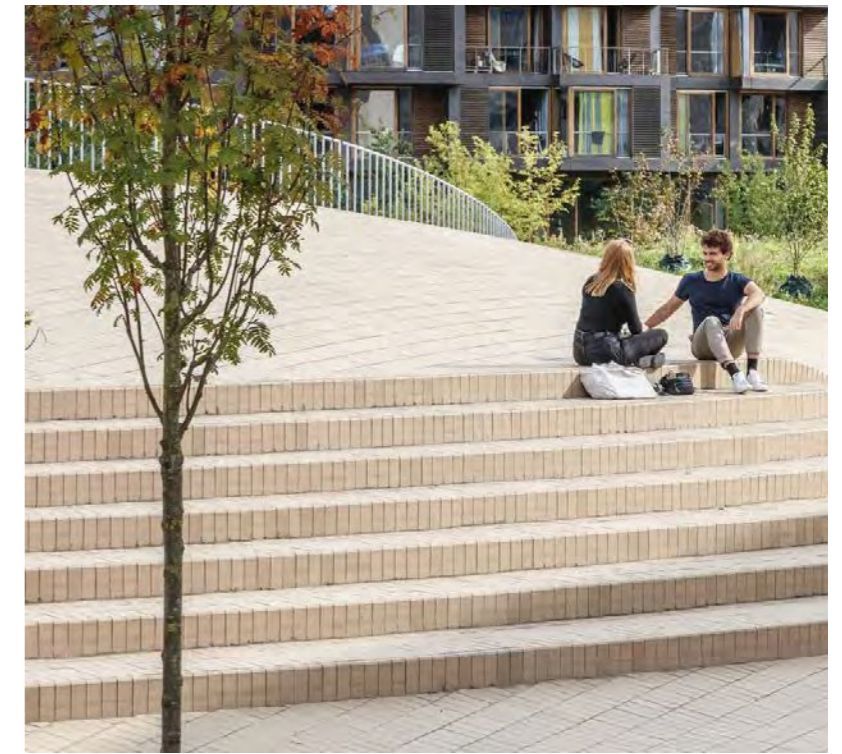
Eksempel på trappetrinn utformet som en naturlig del av dekket. Fra Karen Blixens Plads i København av Cobe Architects.
