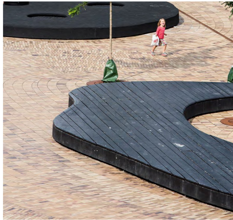
Eksempel på varierende leggeretning i dekke med marktegl. Fra Grønnegade torg i Odense av Masu Planning
