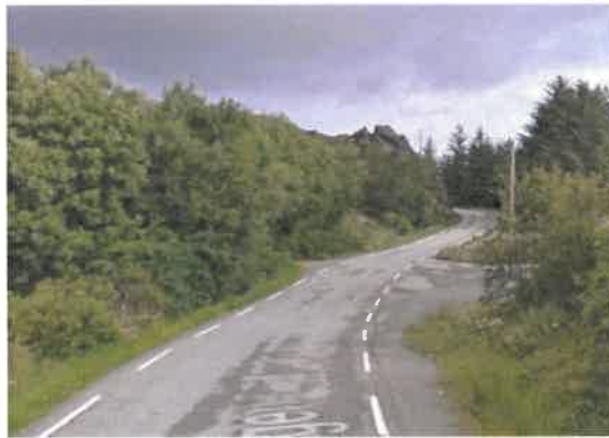
Figur 3-16 – veibane ved planområdet. (mot nord) - kilde google maps.
