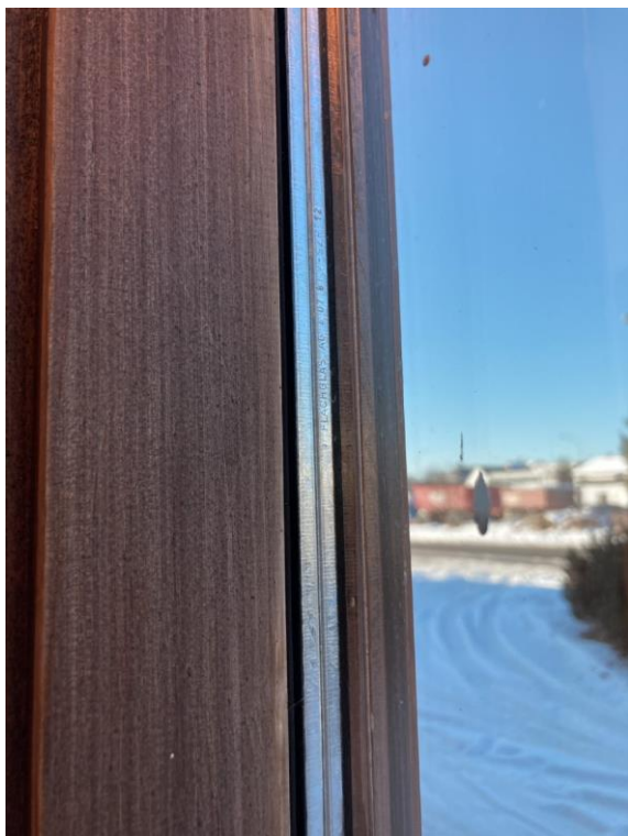
Figur 25: Vindu observert i Telenorbygget, av merket Flachglas. Det ble ikke observert årstall på avstandslisten, men utseendet tilsier at vinduet er eldre, trolig fra oppføringen av bygget. Disse skal håndteres som PCB-holdige.
