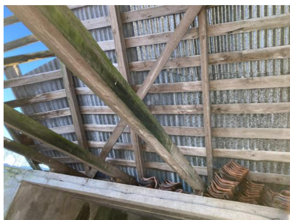
Figur 15: Bilde fra innsiden av låven. Også her er det observert treverk med grønnskjær som skal håndteres som CCA-impregnert trevirke.
