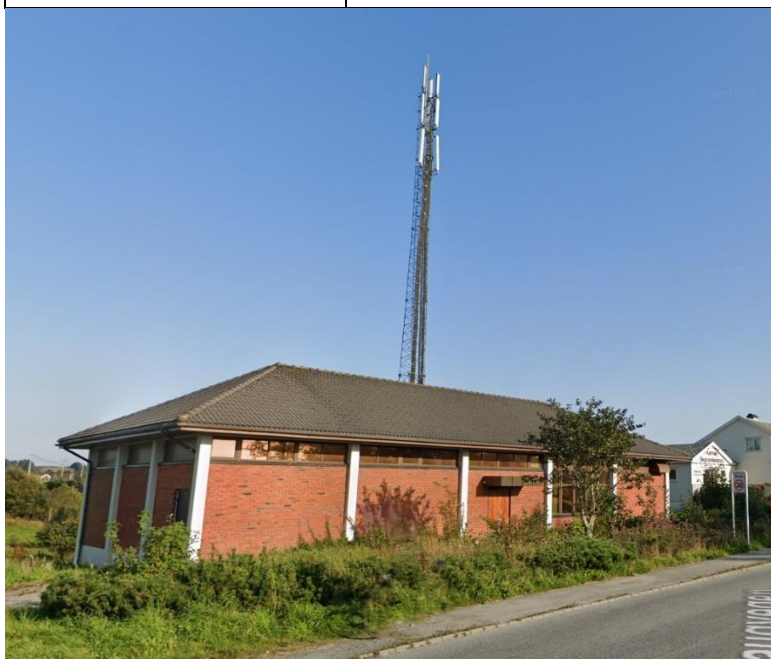
Figur 1: Telenorbygget. Bilde hentet fra Google maps streetview.
