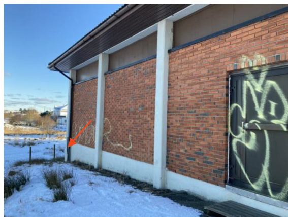
Figur 31: Prøvetakingspunkt for betongsøyle (T17). Denne betongen fikk påvist sink og \text{Cr}^{6+} som hindrer gjenbruk av betongen uten søknad.
