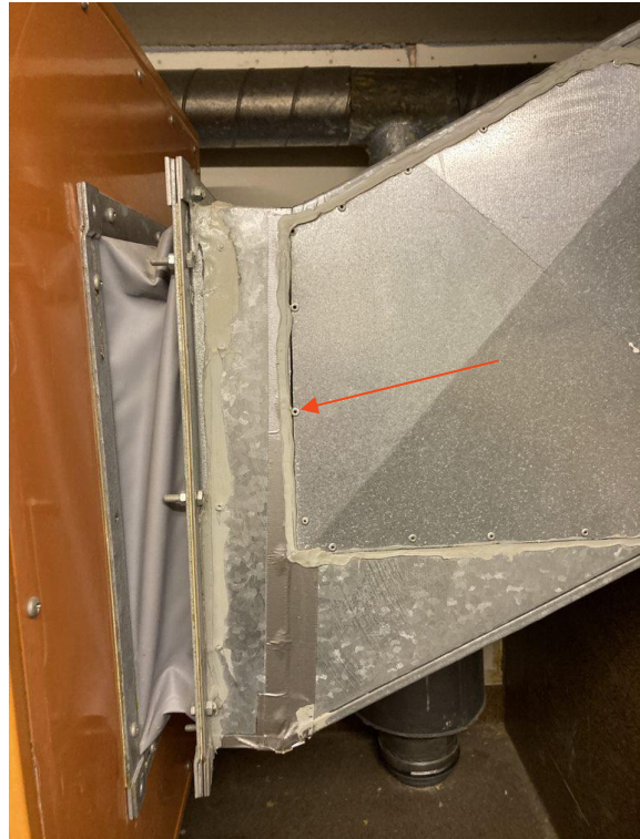
Figur 7: Grå, hard fugemasse på ventilasjonsanlegget ble prøvetatt for asbest, prøve T11 . Det ble ikke påvist asbest i prøven.
