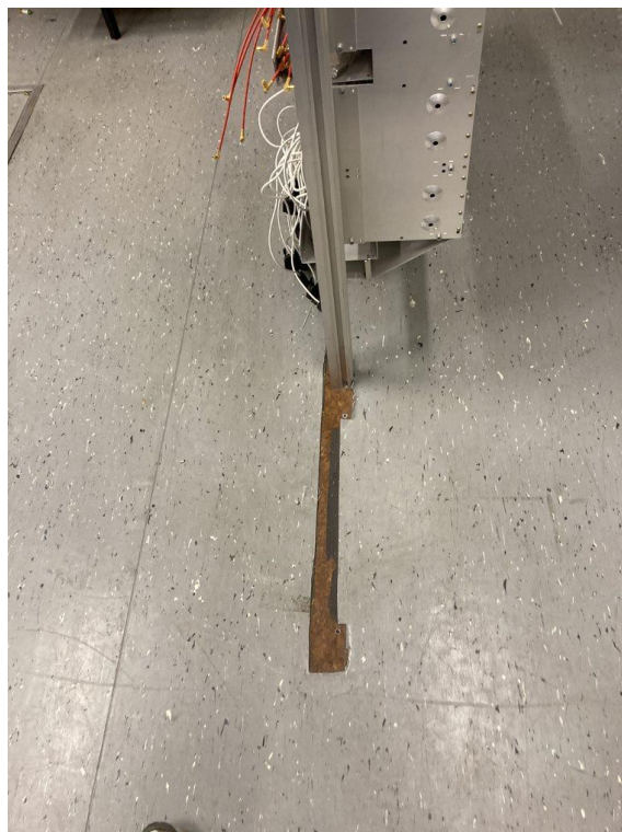
Figur 21: Grå vinyl i rom 112. Her kan man se at vinylen er lagt oppå brun vinyl.
