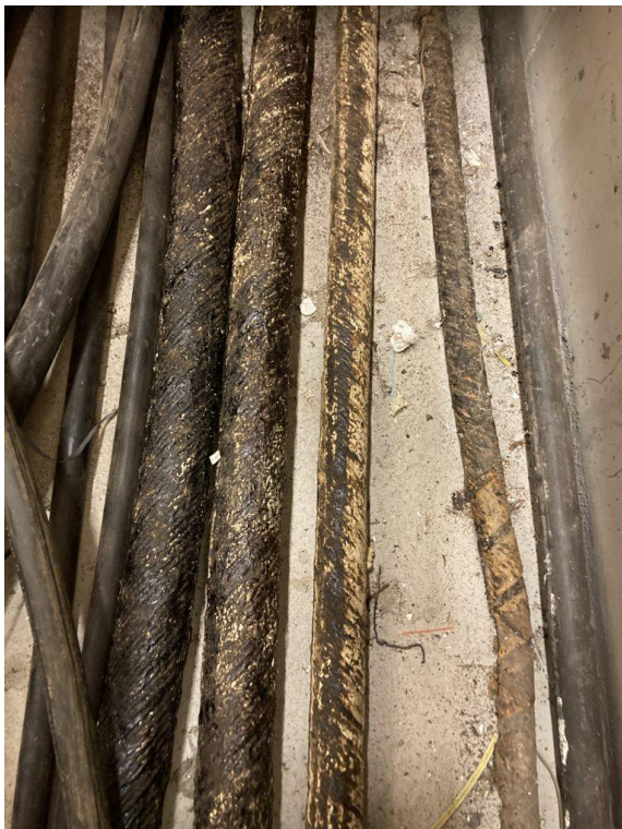
Figur 18: Det ble observert eldre trykksatte kabler i kabelganger under gulvet (rom 113). Disse kan inneholde PCB-holdig olje. Under demontering må kablene håndteres på en slik måte at eventuell olje ikke søler.
