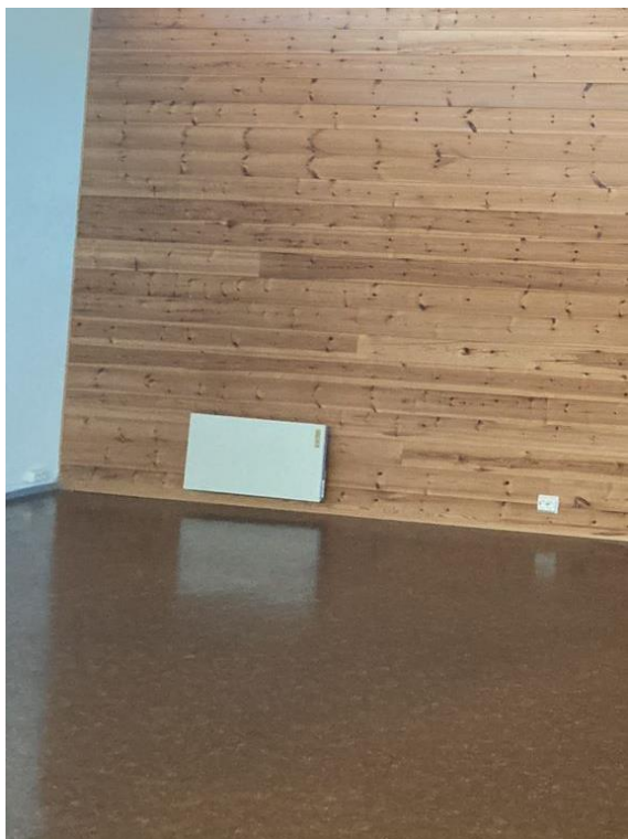
Figur 20: Brun vinyl, prøve T12 . Her i rom 102. Den brune vinylen ble observert i alle rom.
