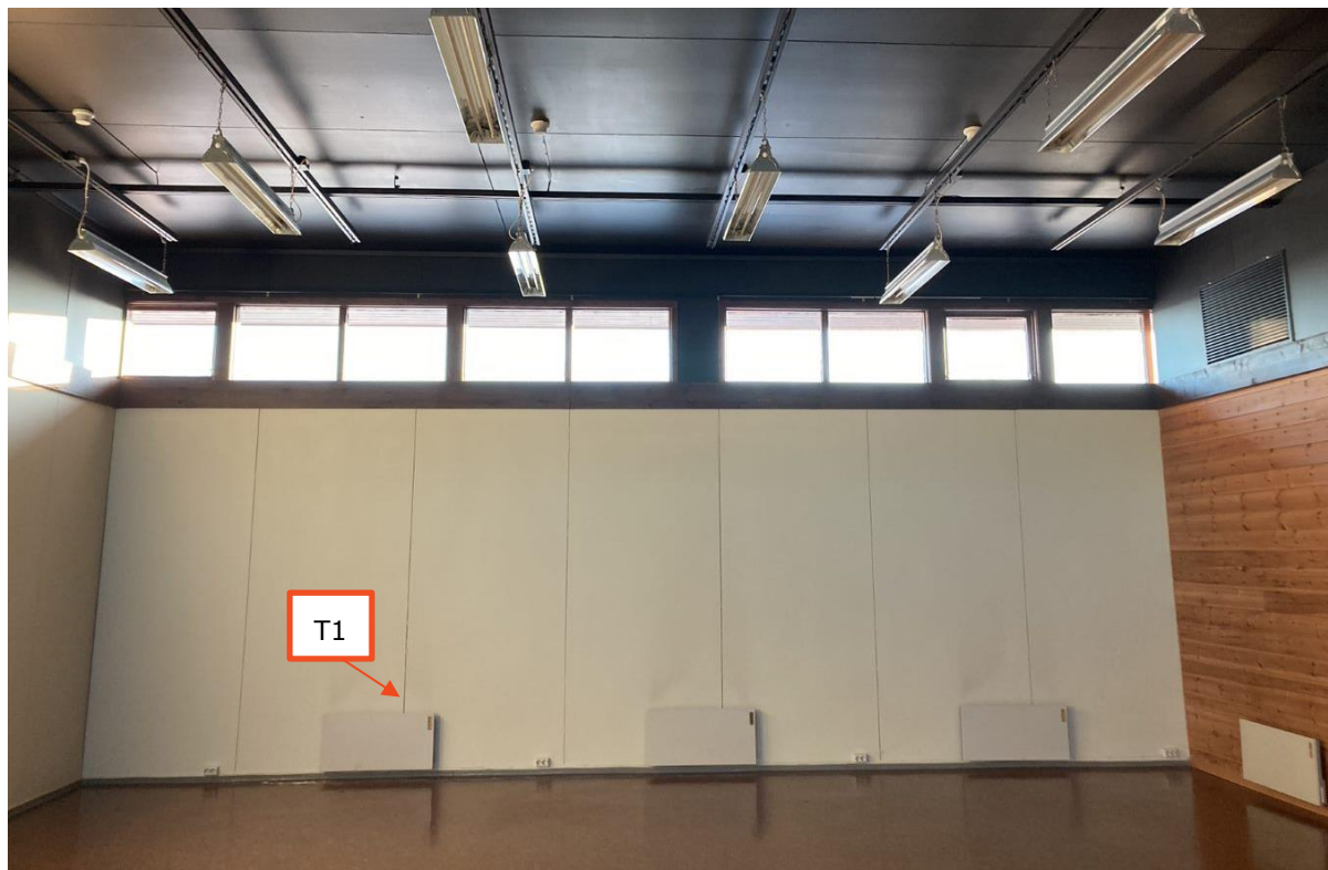
Figur 3: Veggplater og takplater med asbest dekket tak og vegger i mesteparten av Telenorbygget. Bildet er tatt i møtesalen, rom 102. Veggplatene ble prøvetatt her ( T1 ). Taket er dekket med svartmalte takplater ( T4 ).
