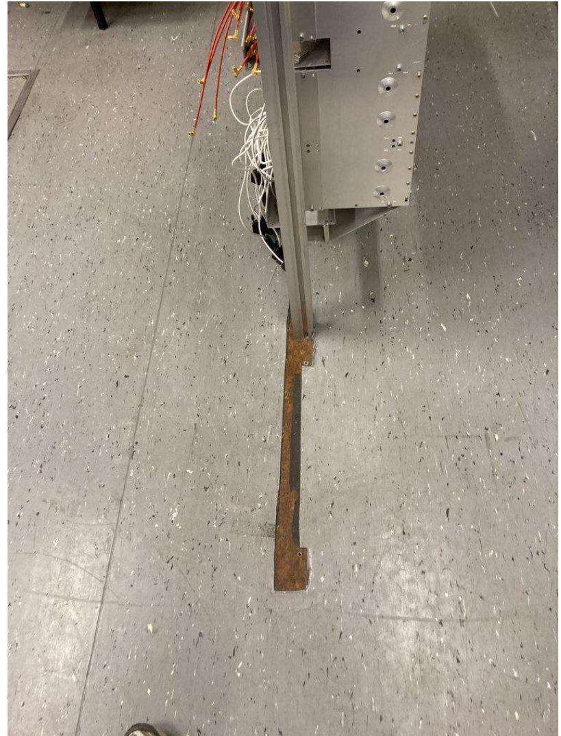
Figur 21: Grå vinyl i rom 112. Her kan man se at vinylen er lagt oppå brun vinyl.
