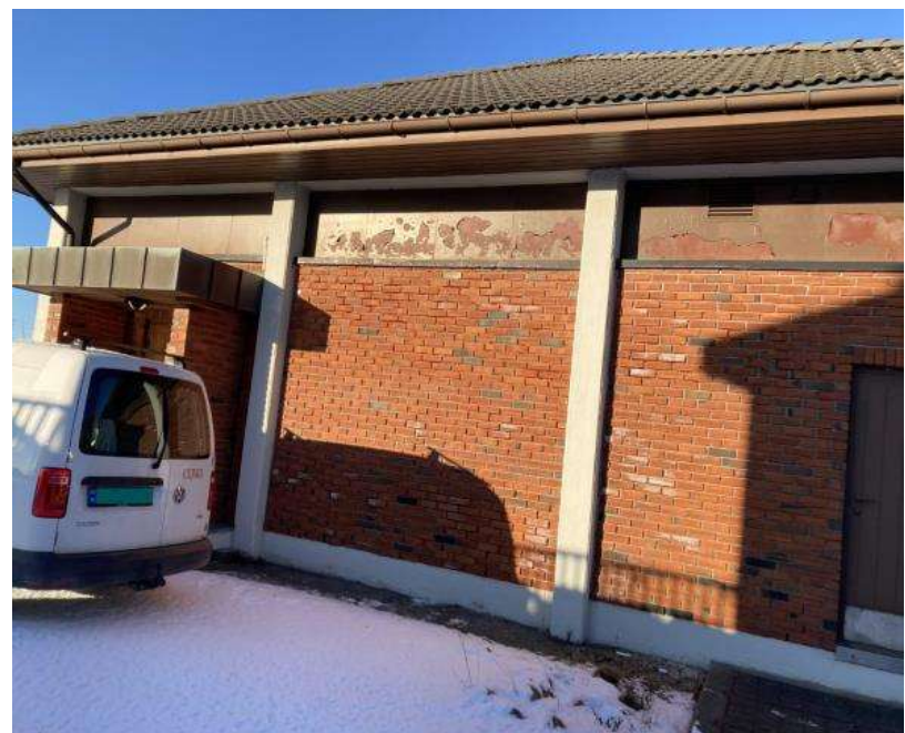
Figur 29: Prøvetakingspunkt for mørtel (T14) og murstein (T15).
