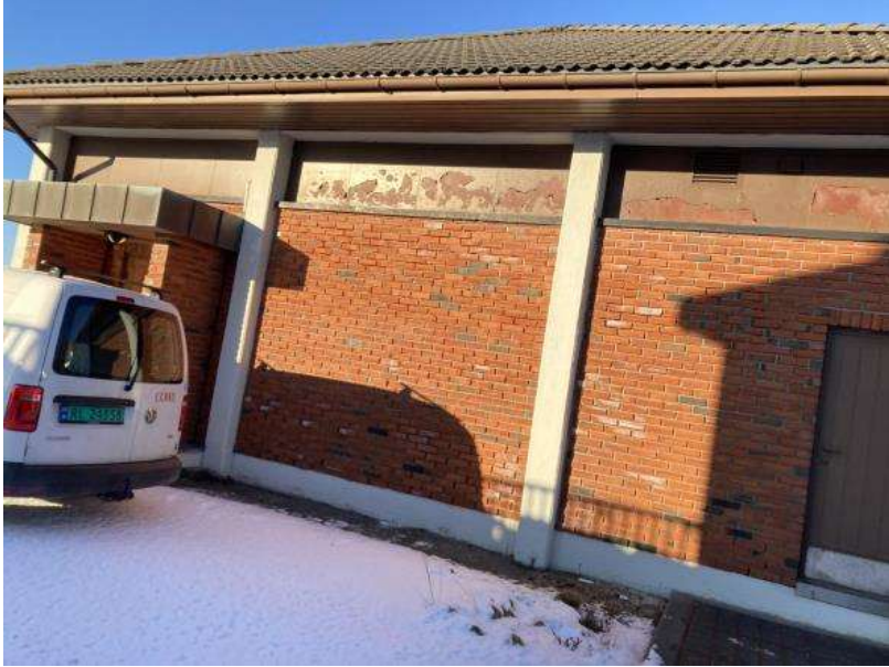
Figur 10: Mørtel mellom murstein på fasaden ble prøvetatt og analysert for asbest, prøve T14 . Det ble ikke påvist asbest i prøven.
