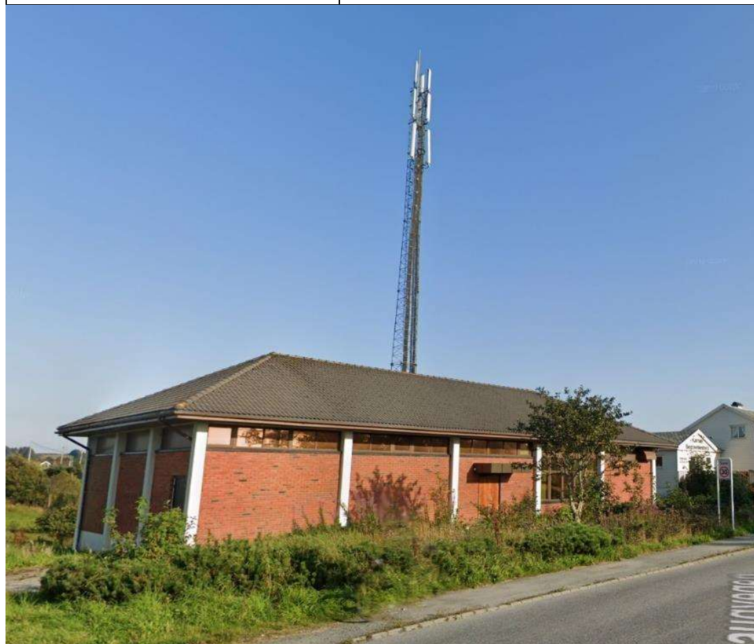
Figur 1: Telenorbygget. Bilde hentet fra Google maps streetview.
