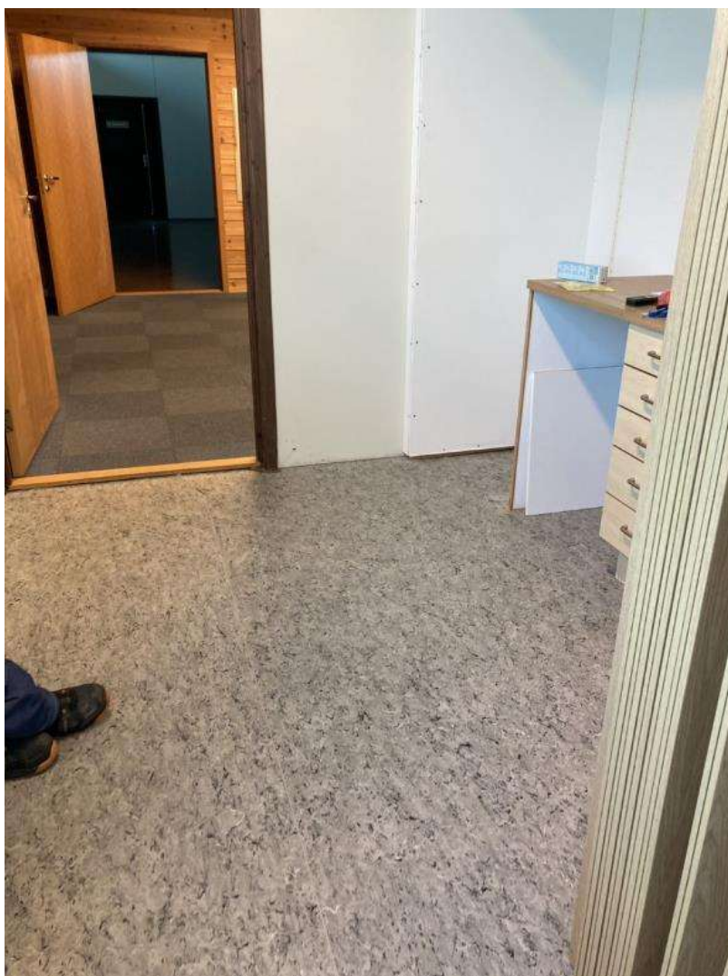
Figur 22: Det ble observert to typer grå vinyl i bygget. Dette er i kjøkkenet, rom 105.
