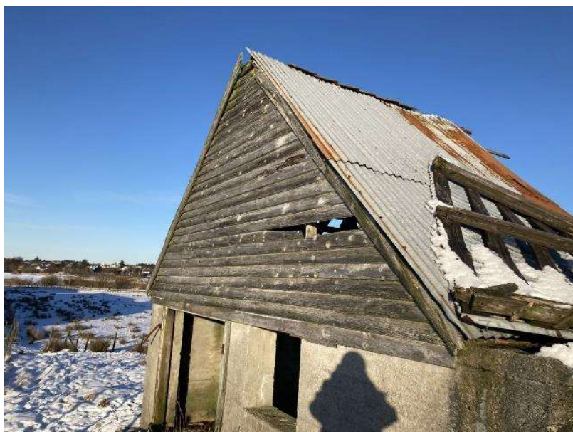
Figur 14: Låven har treverk med grøntskjær som sannsynligvis er CCA-impregnert.
