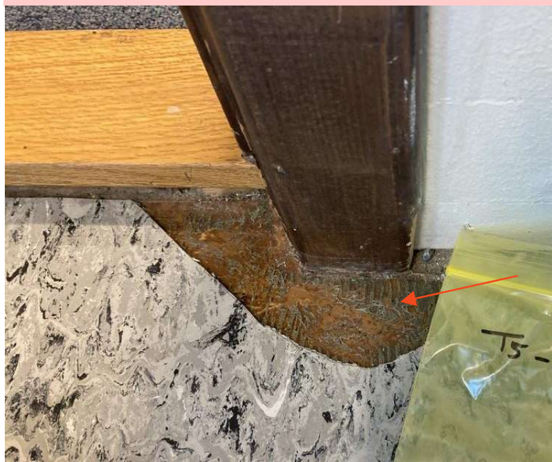
Figur 4: Det ble ikke påvist asbest i limen mellom brun og grå vinyl i rom 105, prøve T5 .
