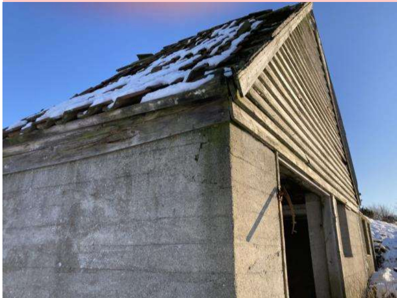
Figur 32: Taksteinene i tegl på låven ble prøvetatt og analysert for tungmetaller (T18). Det ble ikke påvist innhold av tungmetaller som hindrer gjenbruk av teglen.
