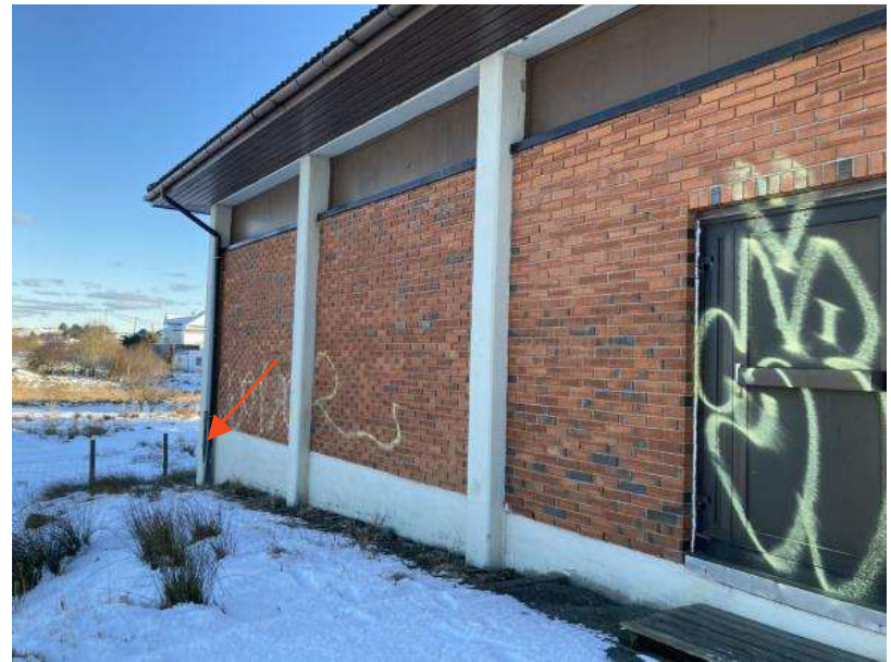
Figur 31: Prøvetakingspunkt for betongsøyle (T17). Denne betongen fikk påvist sink og Cr^{6+} som hindrer gjenbruk av betongen uten søknad.
