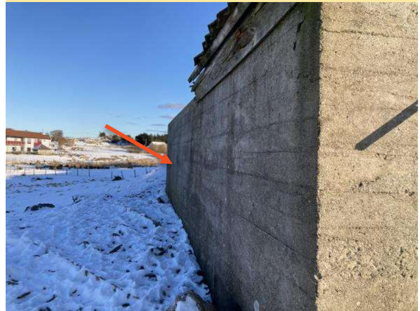
Figur 33: Prøvetakingspunkt for betongen på låven (T19). Betongen ble analysert for PCB og tungmetaller inkludert Cr^{6+} . Det ble ikke påvist nivåer av disse stoffene som hindrer gjenbruk av betongen.
