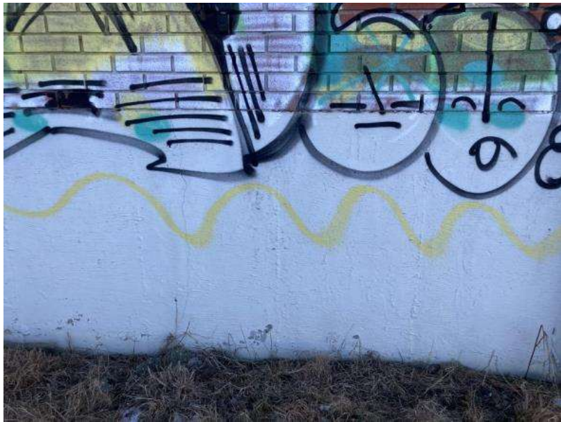
Figur 30: Prøvetakingspunkt for hvit fasademaling (T16). Malingen er farlig avfall med sink.
