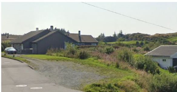
Figur 06 – planområdet 499-12 fra nord ved adkomst.
