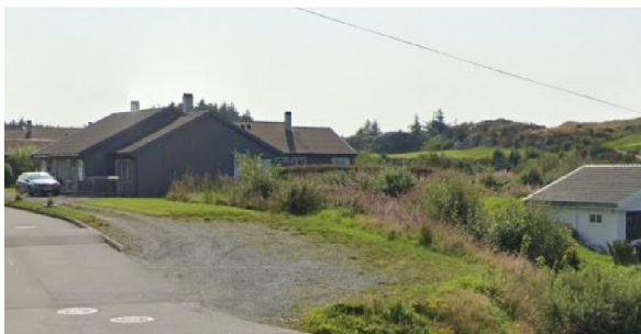
Figur 06 – planområdet 499-12 fra nord ved adkomst.
