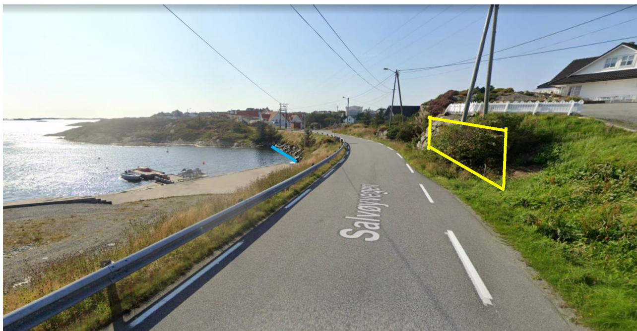
Figur 8: Mur 1 t.v. (blå) og mur 2 (gul) t.h. omtrentlig tegnet inn for orientering.
