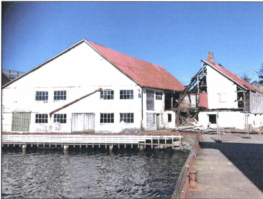
Bilde 3: Bygningsmasse til forfalls Kilde: Tiltakshaver
