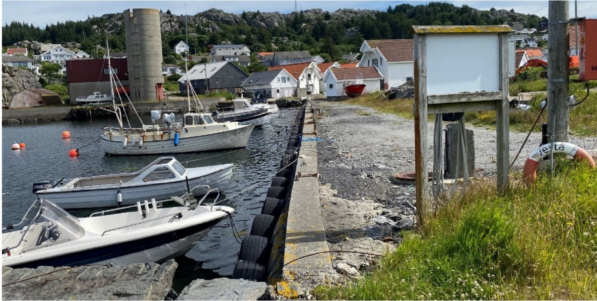
Figur 20 – Støpt betongkant i brygge vest i planområdet.
