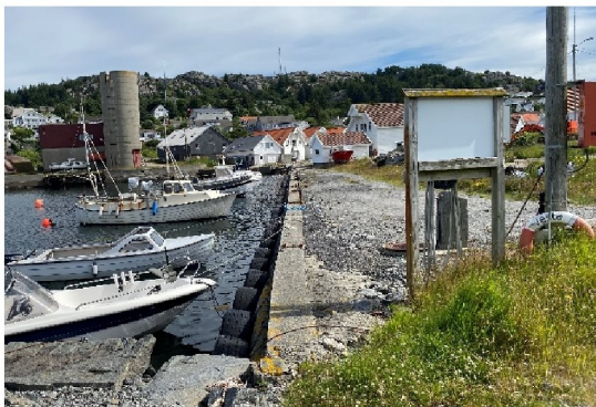
Figur 02 – kai området, ca. 15 cm bryggekant er støpt direkte på massive stein blokker.
