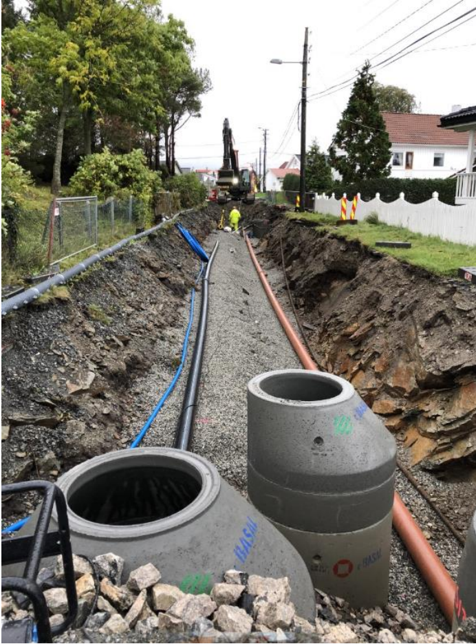
Bilde er fra vann og avløp sanering Åkrehamn
