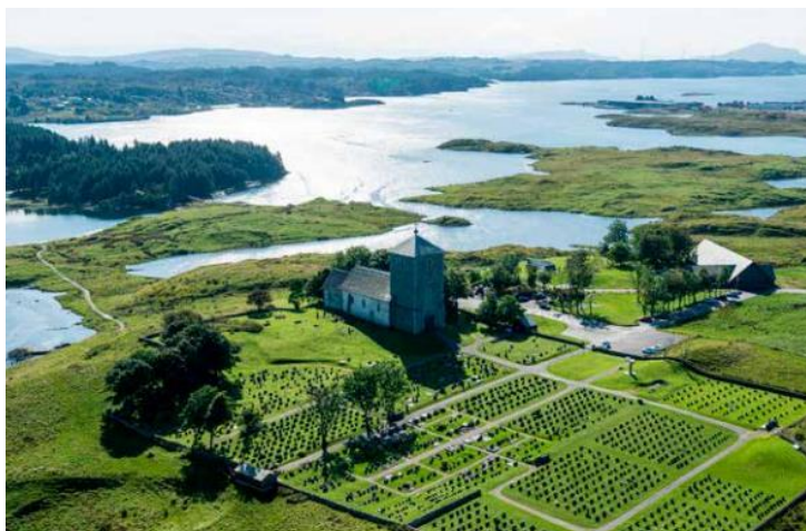
Oversiktsbilde av Avaldsnes kirke og driftsbygningen til høyre
