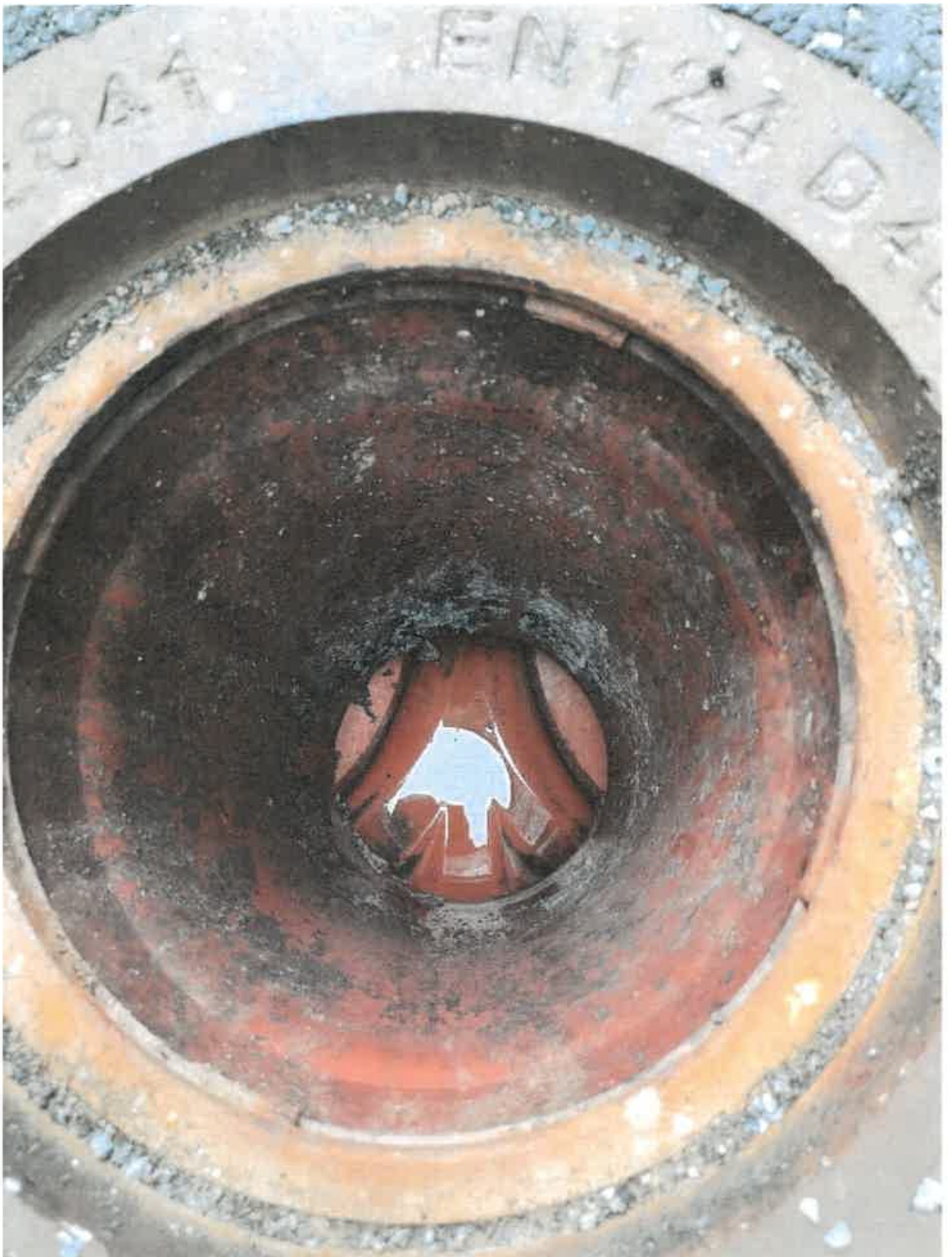
Inspektionsturm für Fettabscheider,
