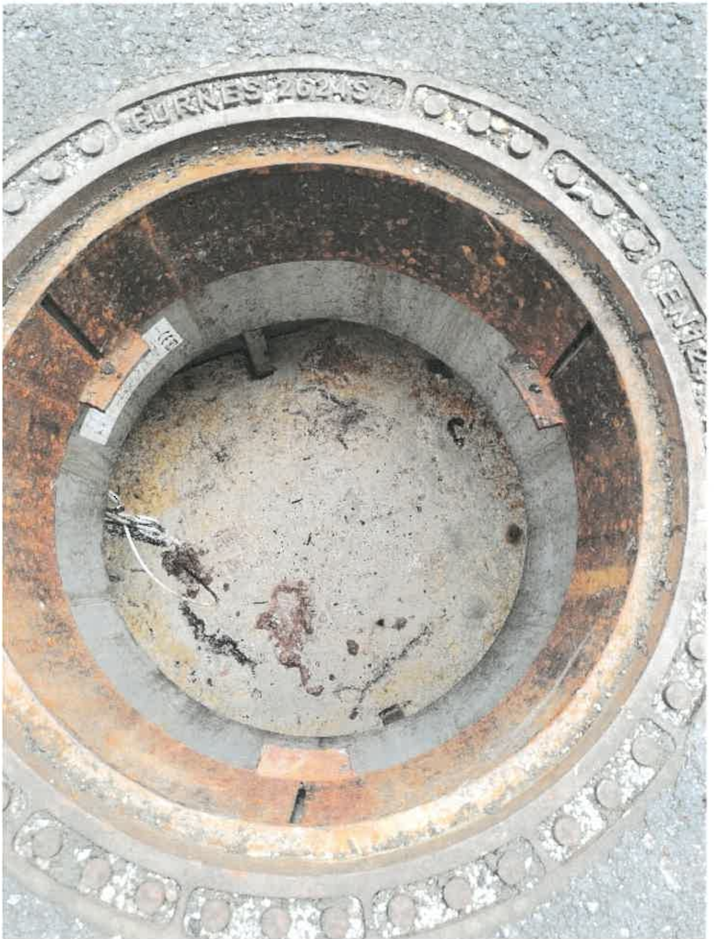
Fektskittler, full tank 86cm fettlag. Max 16cm etter dnn. tabell
