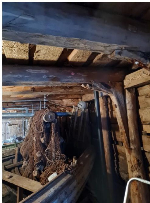
P4 - Bjelke mellom 1. og 2. etasje, like ved langvegg mot vest
