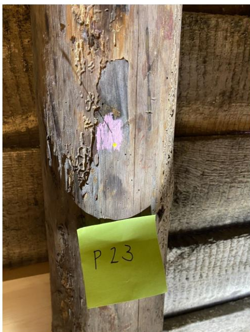
P23 – Prove tatt i stav, ca 1,5 meter over gulv
