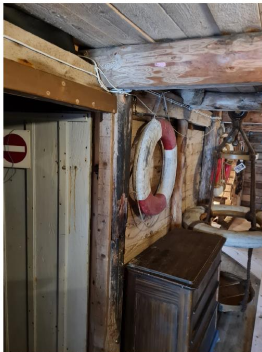
P13 - Bjelke mellom 2. og 3. etasje, over dor i byggets midtre del
