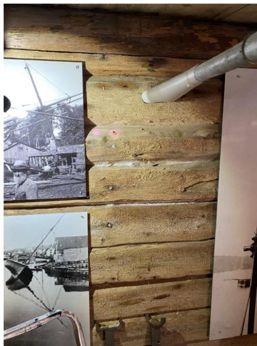
P16B - Lafestokk, 9. omfar i vegg mot sør
