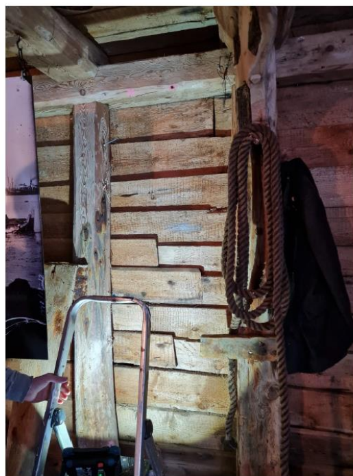
P9 - Toppramme i langvegg mot øst
