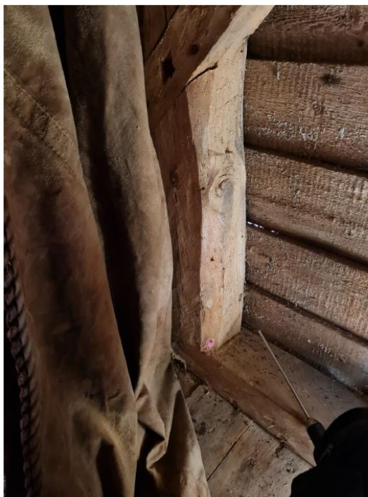
P11 - Stav i gavlvegg mot nord
