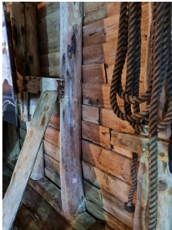
P8 - Stav i gavlvegg mot øst
