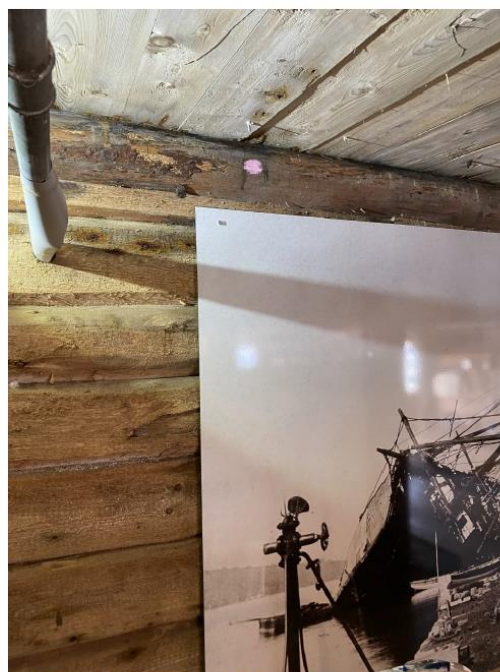
P17 - Bjelkelag mellom 2. og 3. etasje, oppå laftevegg mot sør
