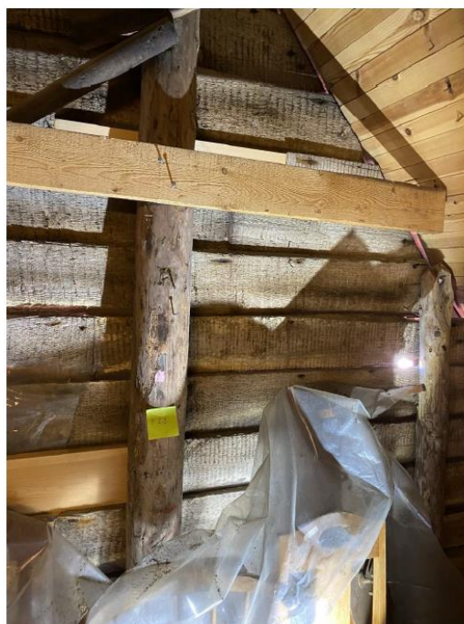
P23 – Stav i gavlvegg mot nord
