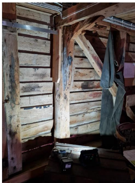
P10A - Stav i gavivegg mot nord
