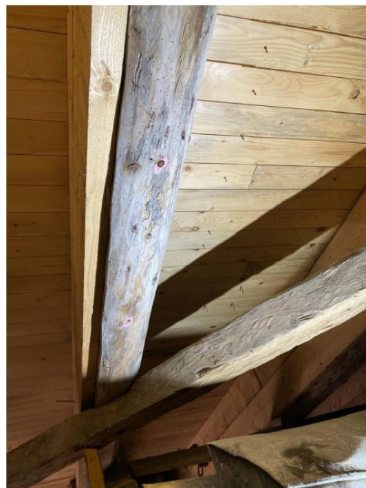
P21 C - Taksperr i vestre takflate
