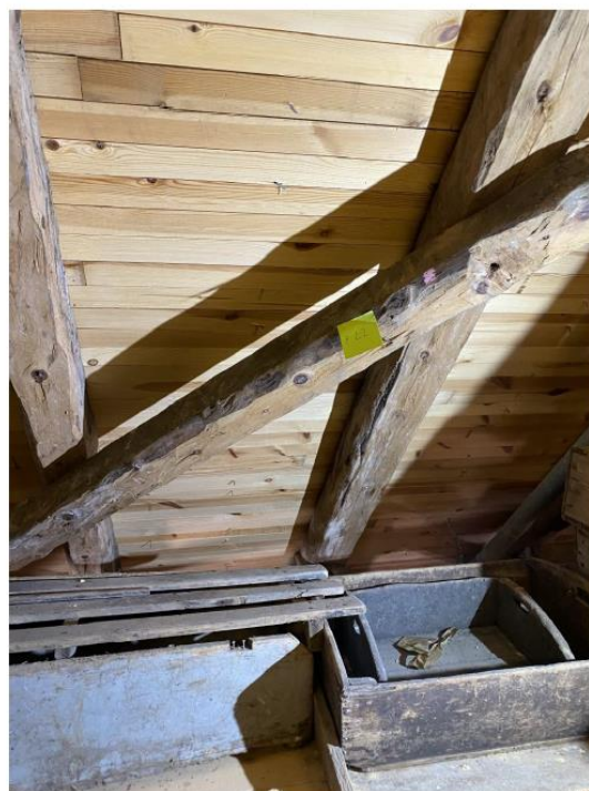
P22 – Skråband under taksperri i vestre takflate
