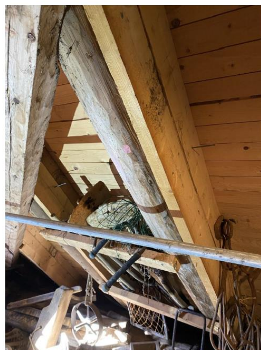
P18 – Taksperr i takflate mot vest
