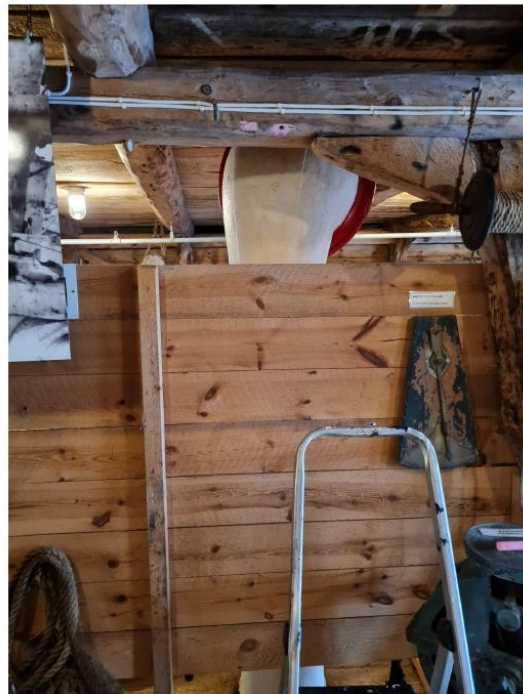
P12 - Toppramme i østre midtvegg
