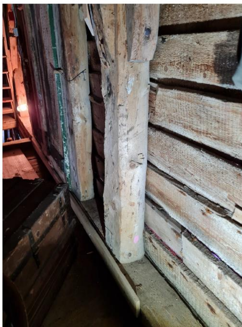
P10A - Stav i gavivegg mot nord
