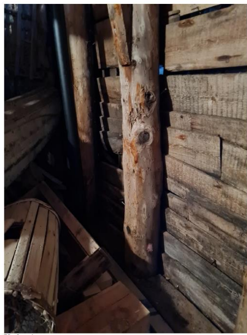
P5 - Stav i langvegg mot vest
