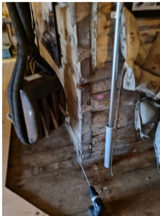
P14 - Lafestokk, 4. omfar i vegg mot sør
