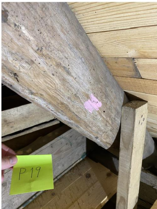
P19 – Prove tatt i nedre ende av taksperre
