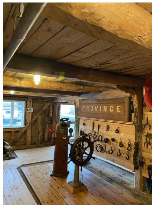
P3 - Bjelke mellom 2. og 3. etasje
