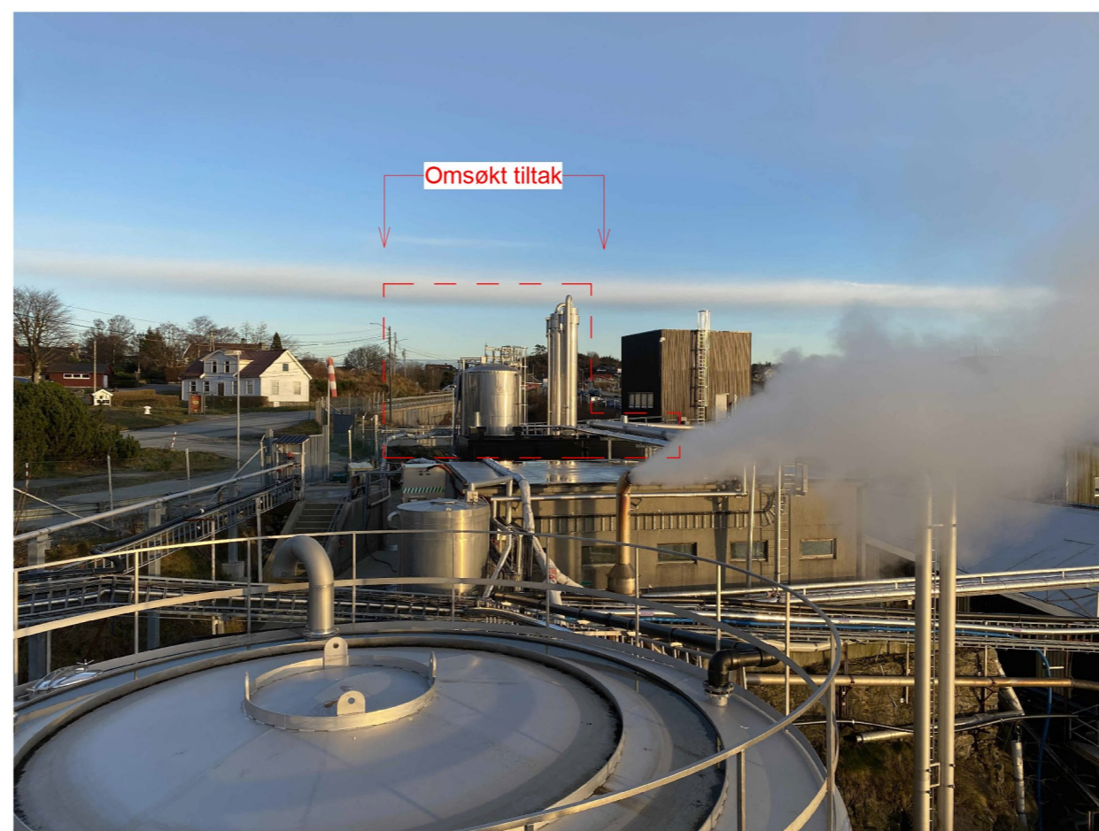
Anlegget sett fra nord
