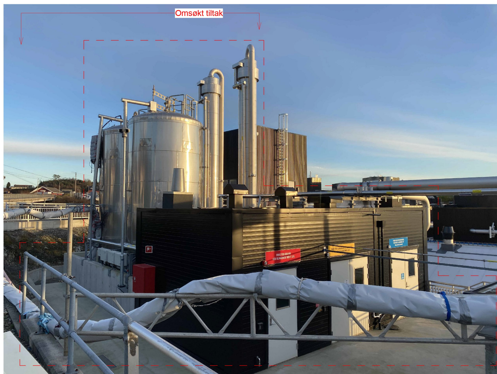
Anlegget sett fra nord-vest
