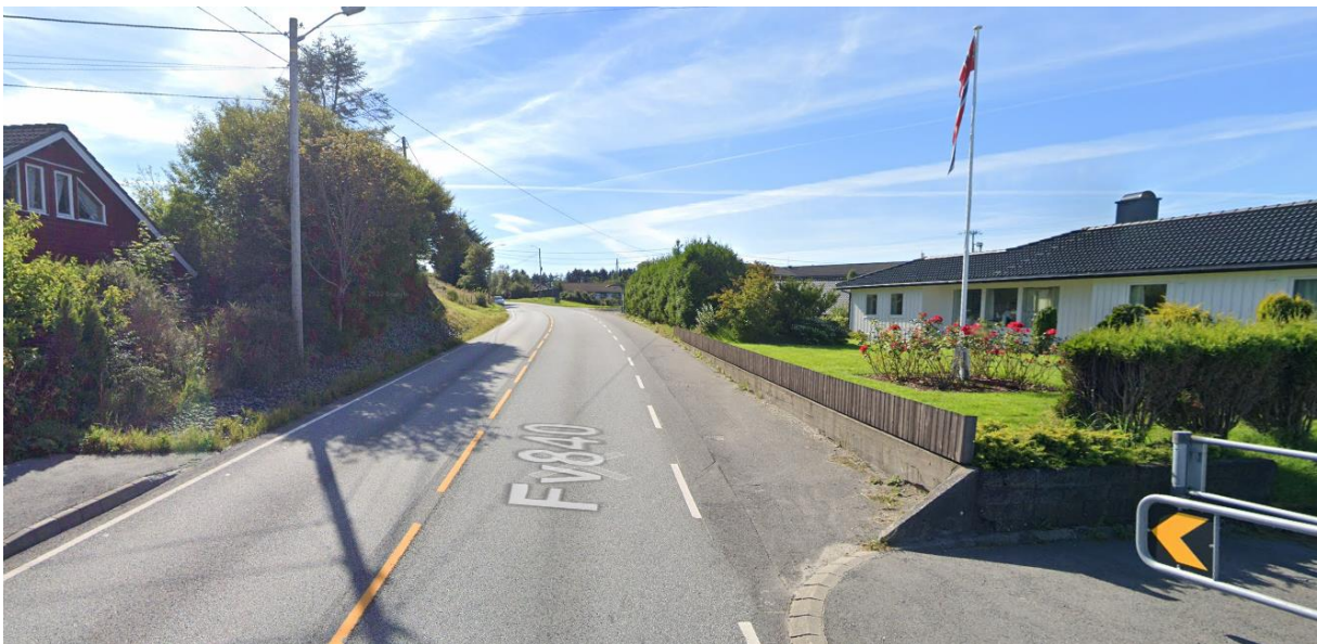
Det samme krysset sett fra nord. Det vil bli opparbeidet fortau på begge sider av vegen, fra Trondsvågen til gangfeltet på vegen venstre side, og fra snarvegen i høyre bildekant fram til Bjørgevegen.
