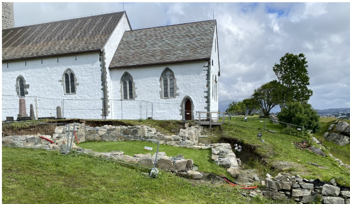
Tårnruinen sett mot nord
