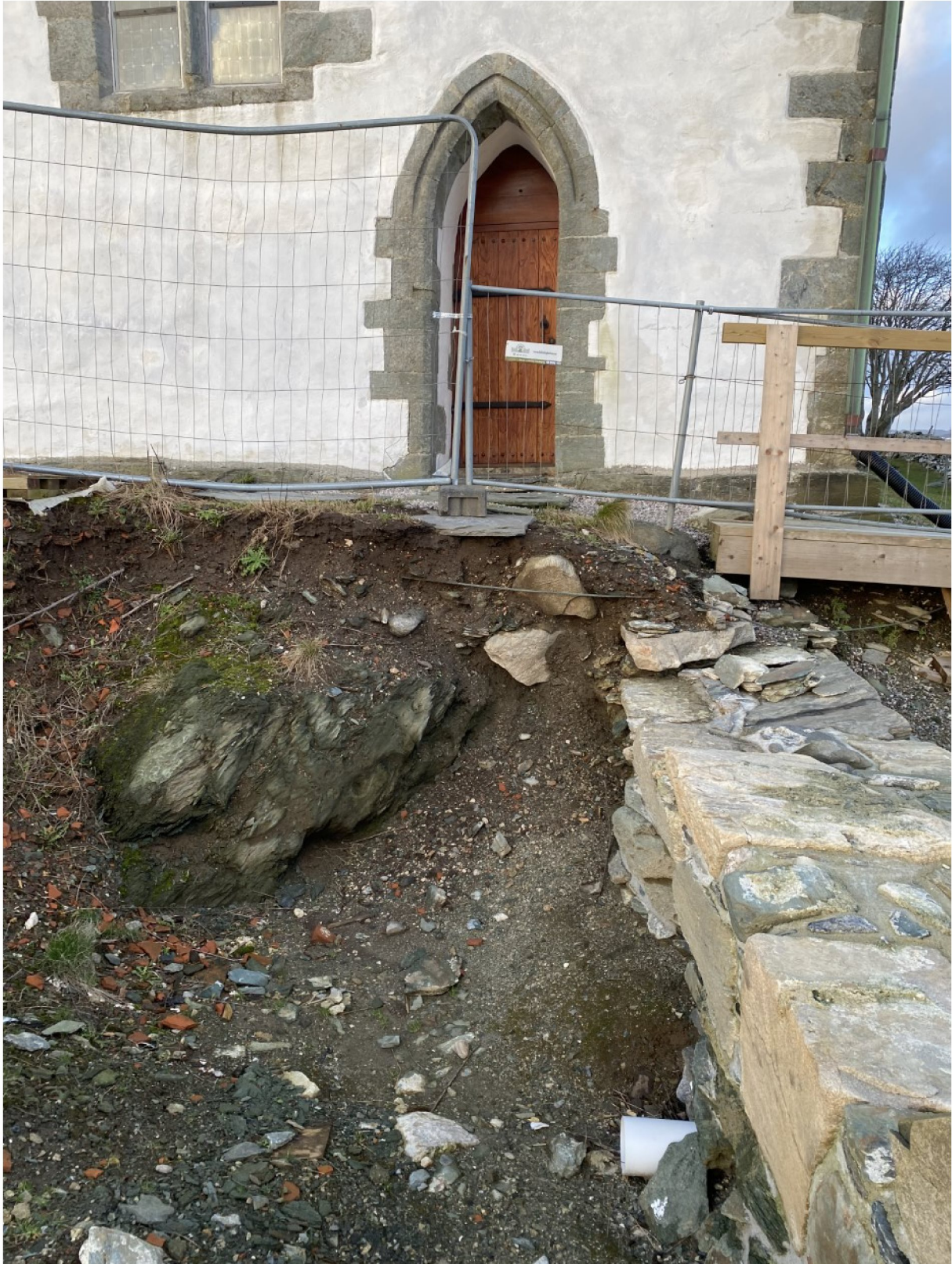
Områdene 11,12, 13 og 14 ved forbindelsesmuren nord for tårnruinen
