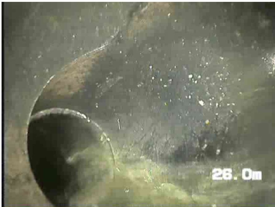
17.06.2022 12_51_21_5835b00e-8b2f-45c9-a02b-46d6b605f07d_20220617_130119_102.jpg, 00:04:02, 26.00 Inspeksjon fullført / hovedledning
