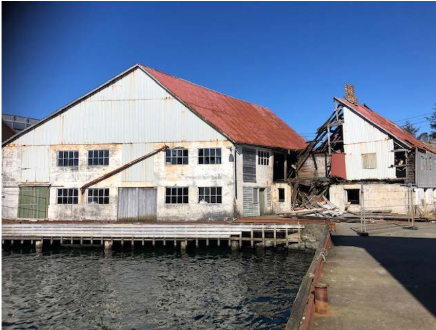
Bilde 3: Bygningsmasse til forfalls Kilde: Tiltakshaver
