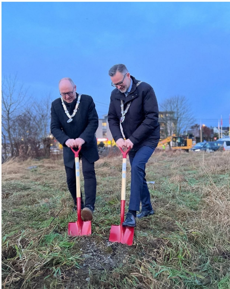
Første spadestikk nye lokalveier i Åkrehamn ved fylkesvaraordfører og Karmøyordfører. Foto: Anne Torland
