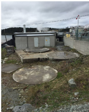
Bilde 5: fundamenter etter tre stk. tidligere tanker, som kan ses i bilde 3.
