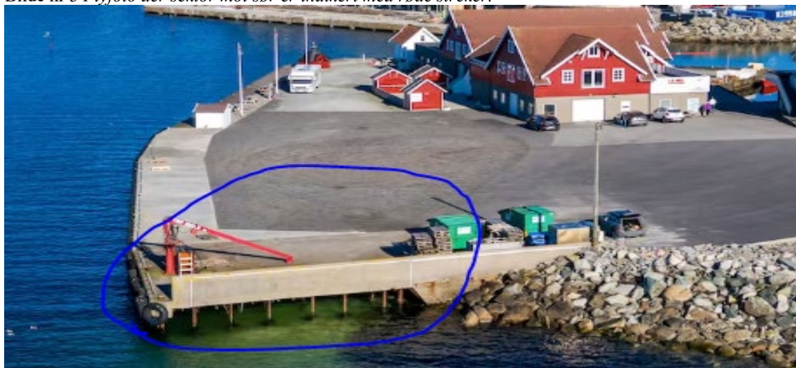
Bilde nr 3B Bilde viser etablert betongbrystning i sør på tomten (høyde ca 1,5m fra terreng på kote 1.55)
