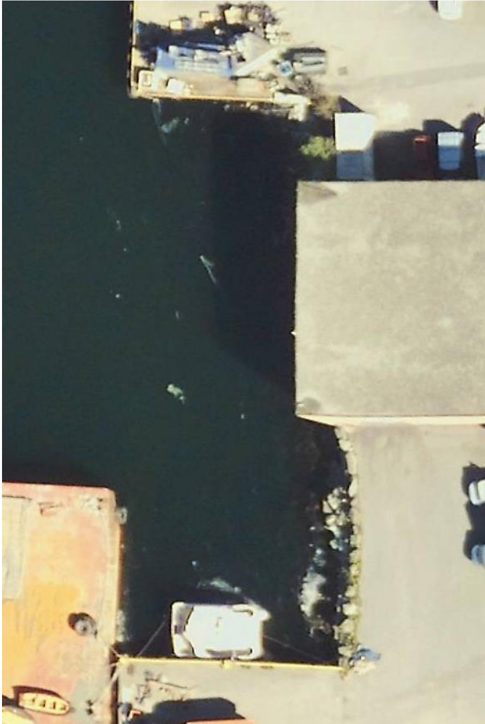
Bilde 1: Oversiktsbilde over området som ble inspisert.
