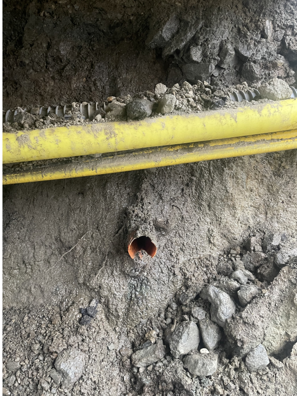
SI 0,00m Fra grøft mot hus
