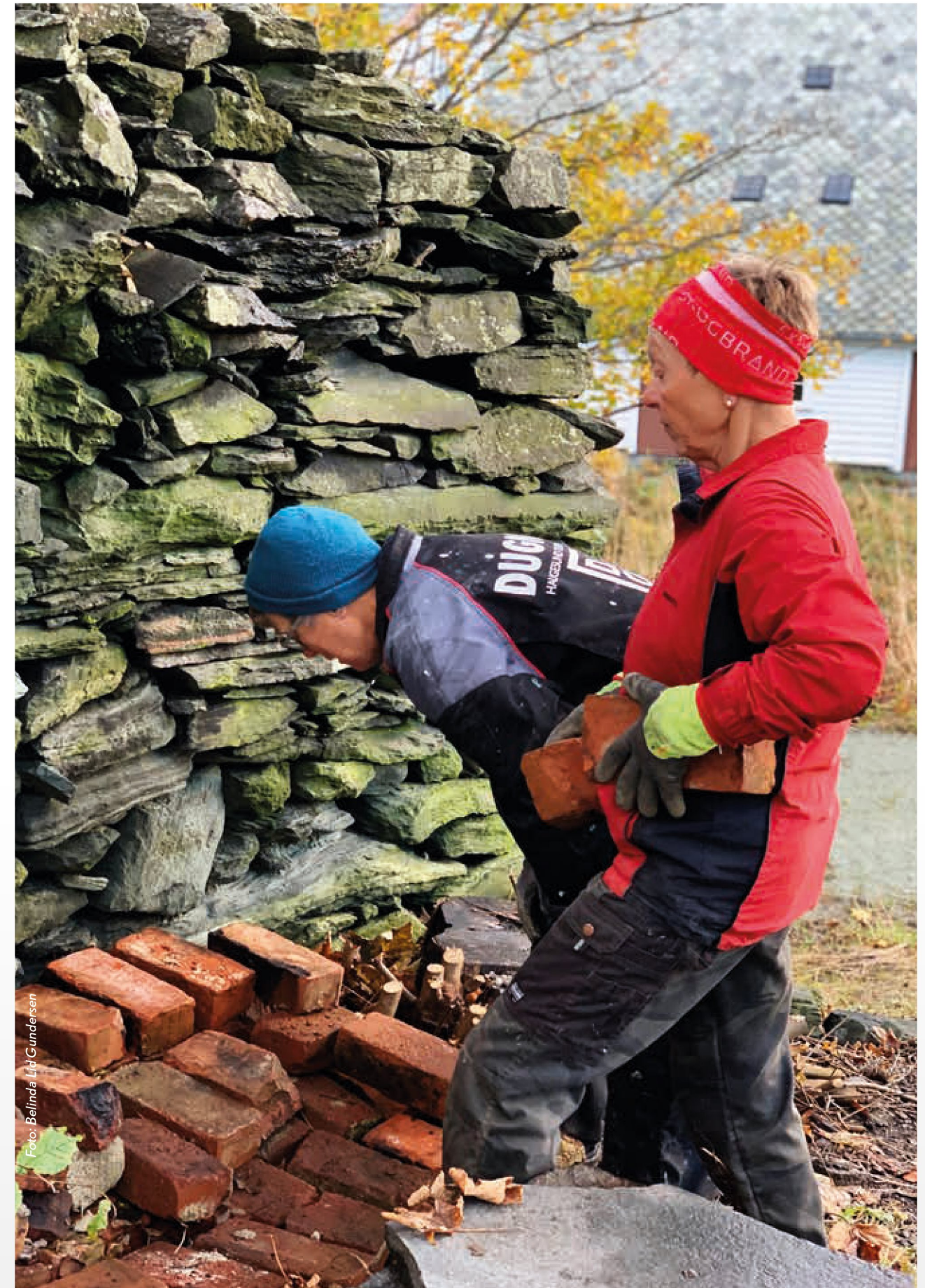
Dugnad på Vibrandsøy.
