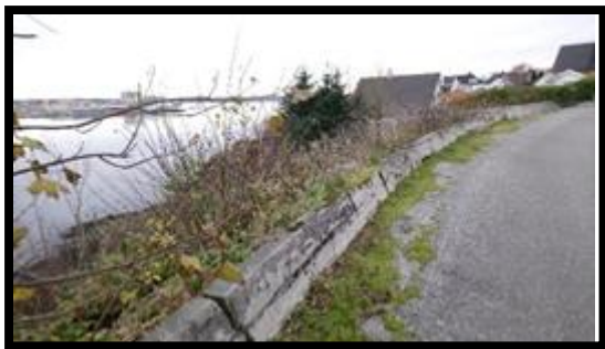
Figur 12. – Ved adkomst fra Møllevegen, sett mot sør.
