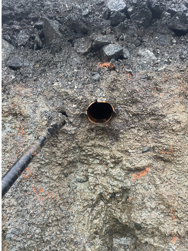
SI 0,00m Fra grøft mot hus
