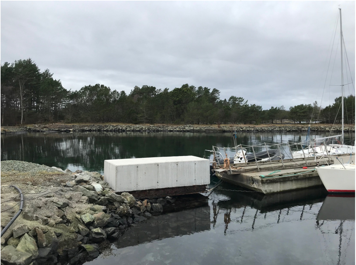
Nytt landkar ferdigstøpt
