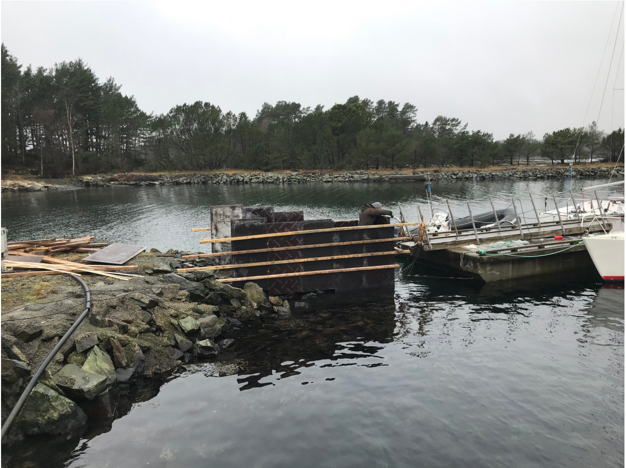
Støping av nytt landkar
