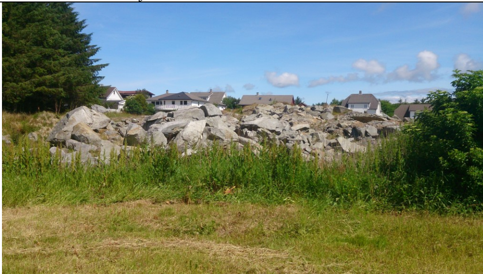
3. Sprengt del av fjellknaus – sett fra sør.
