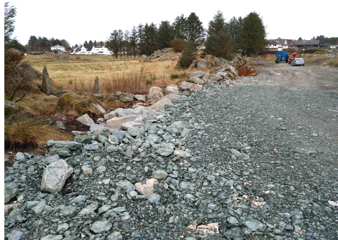
2. Etablering av fast traktorveg langsetter eiendomsgrensen i vest.
