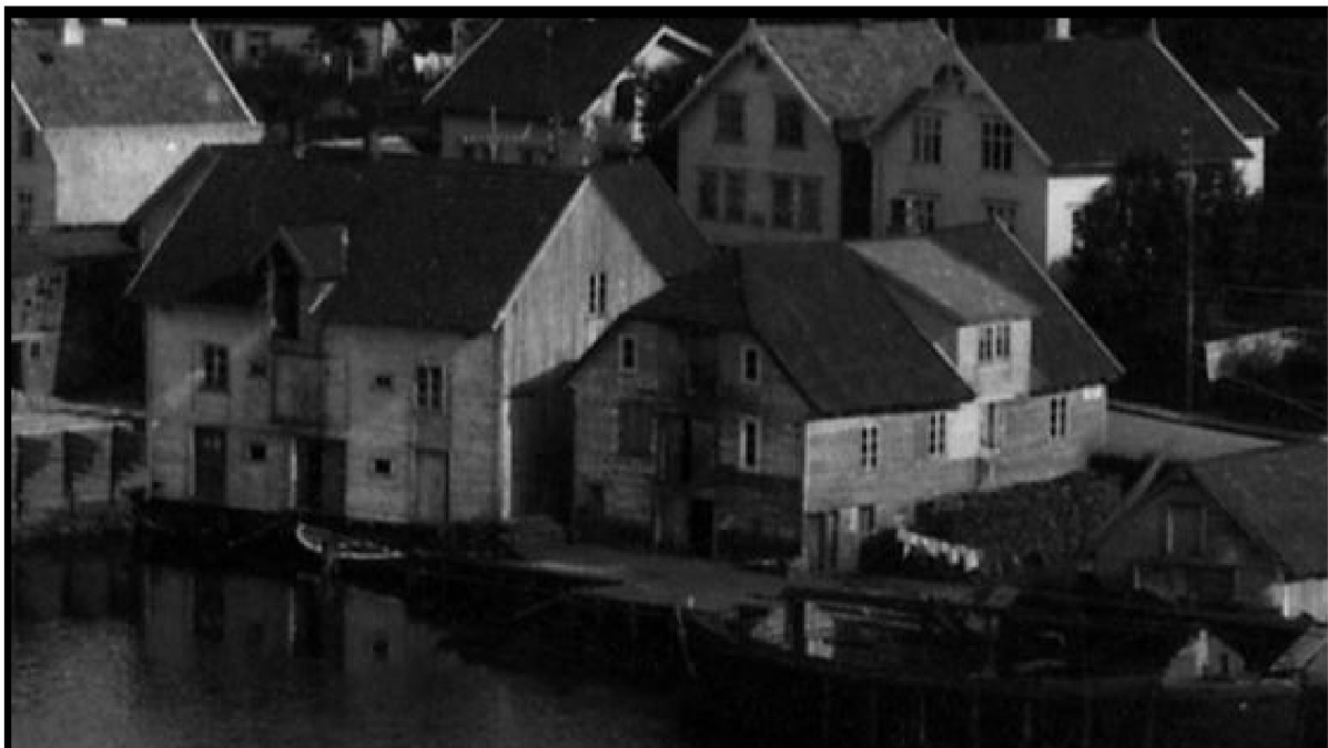
Figur 21: Historisk bilde av eiendom 58/10. Byggene i bildet er erstattet.
