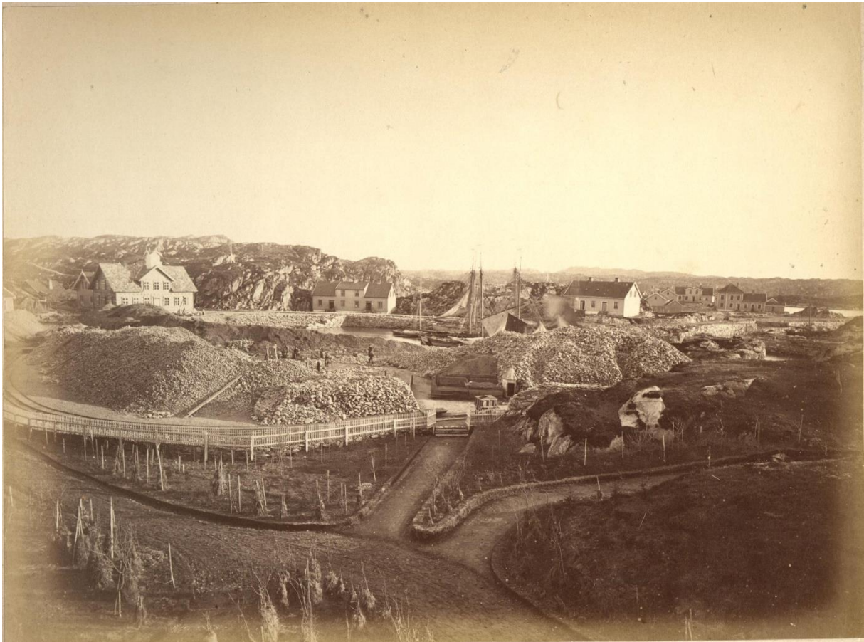
Deler av Fransenhagen sett fra direktørboligen. Til venstre i bildet ligger administrasjonsbygningen
