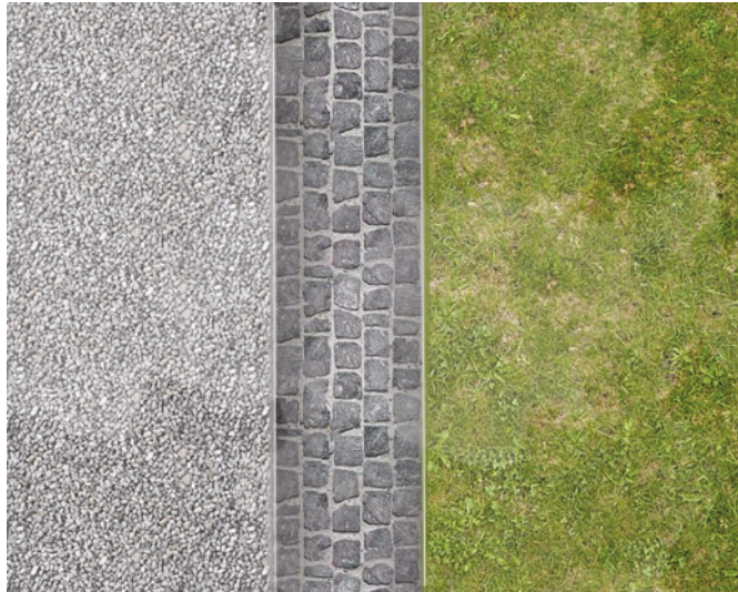
Avgrensning mellom grusareal og gras. Brostein i smågatestein format.
