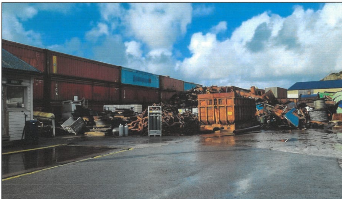
Figur 4-4: Deler av containerveggen som skjermer mot Veavågen, sett inne fra industriområdet.
