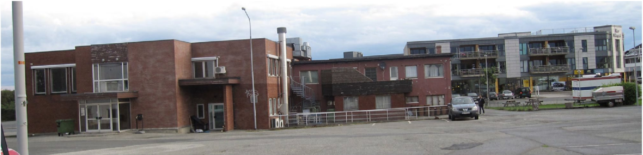
Over: Mot sør sett fra parkeringsplass.
