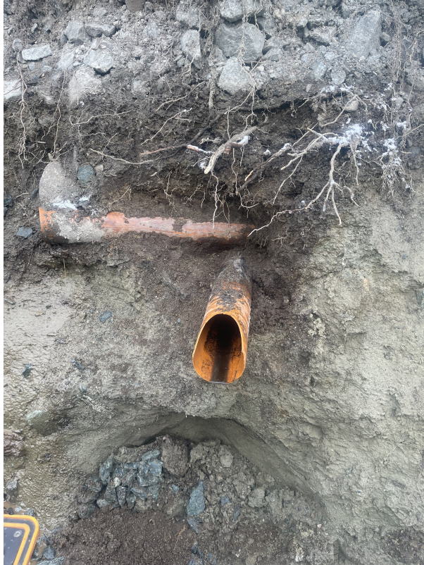
SI 0,00m Stikk i grøft
