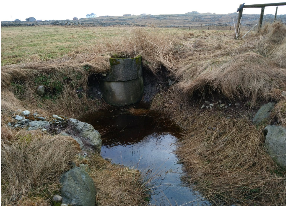
4. Dreneringskum, start grøft i sørøstlig del.
