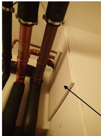
Bilde 30 viser plater på vegg i rom 052. Det ble ikke påvist asbest i platen.
