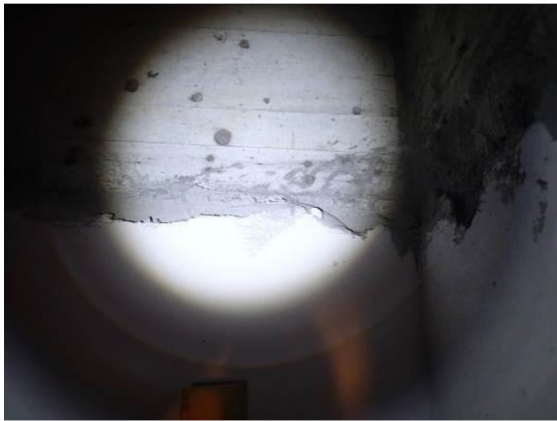
Bilde 65 viser murpuss prøvetatt i rom 005. Murpussen er ren og kan disponeres fritt så lenge den ikke er malt.
