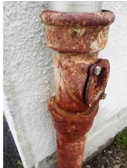
Bilde 45 viser eksempel på soilrør på fasaden.
