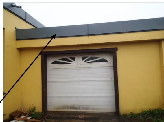
Bilde 46 viser metallbeslag som er på fasaden av hele bygget.
