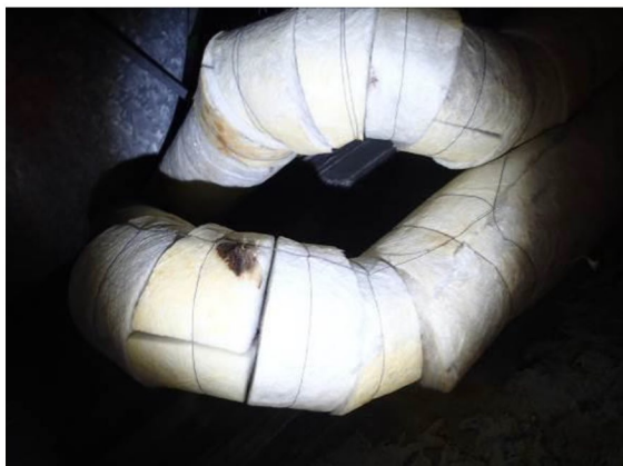
Bilde 18 viser hvit isolasjon på ventilasjonsrør. Ikke påvist asbest.
