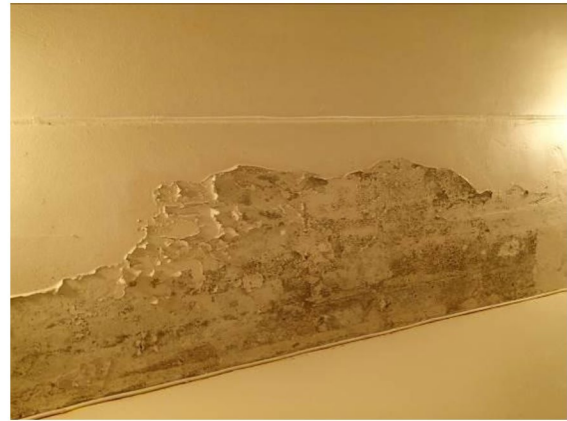
Bilde 66 viser hvit maling i tak prøvetatt i rom 015. Malingen er forurenset, men ikke over grensen for farlig avfall.
