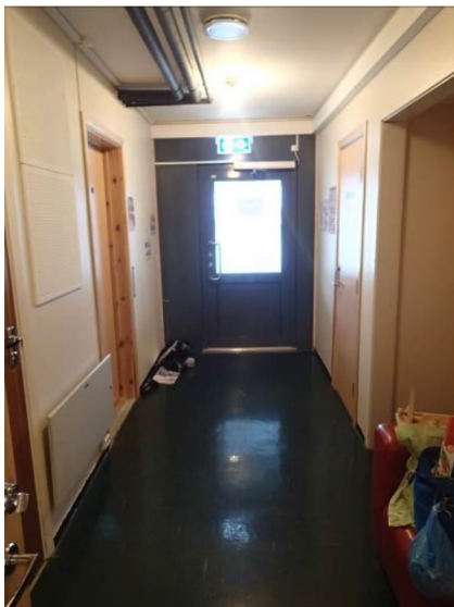
Bilde 29 viser mørk grønn vinylflis på gulv i rom 048. Det ble ikke påvist asbest i flisene.
