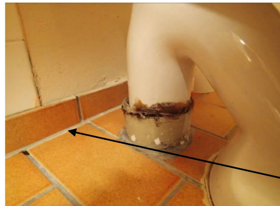
Bilde 59 viser eksempel på fugemasse som leveres som farlig avfall med PCB.
