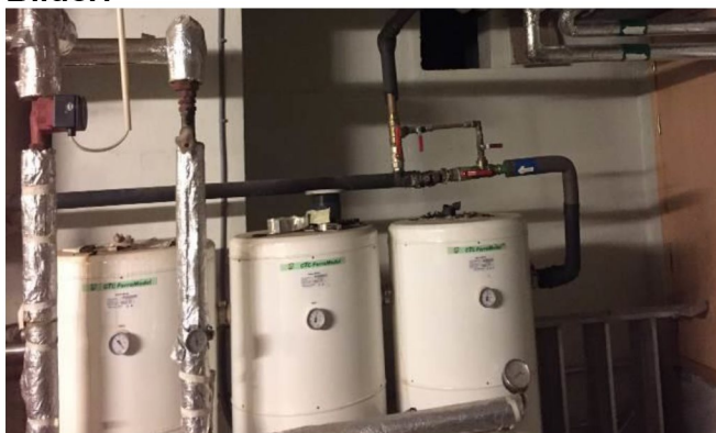
Bilde 57 viser eksempel på termometre som kan inneholde kvikksølv
