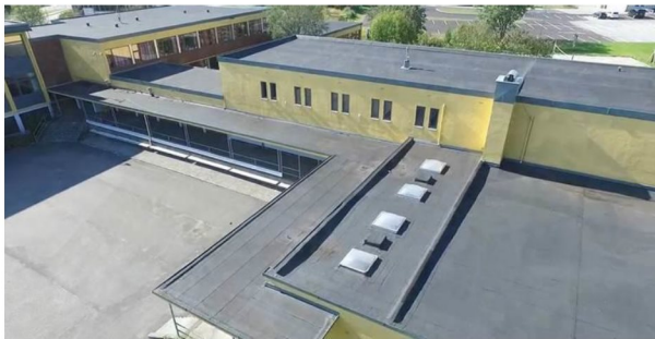
Bilde 62 viser takpapp på bygget. Denne, og limet, må prøvetas ved evt. rehabilitering.
