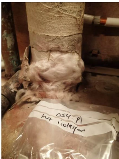
Bilde 32 viser hvit isolasjon på rør i rom 054. Det ble ikke påvist asbest i prøven.
