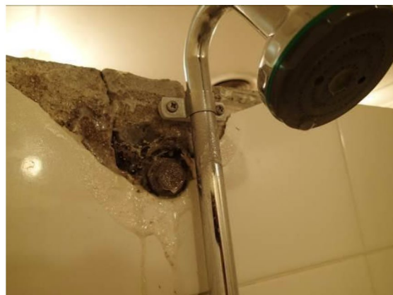
Bilde 25 viser hvit keramisk flis i dusj. Brun isolasjon/tettemasse rundt rør i vegg. Det ble ikke påvist asbest i prøvene (009-P1 og -P2).
