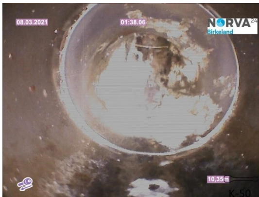
Spillvann_Inn til hus_Septik tank_20210308_110118.jpg
