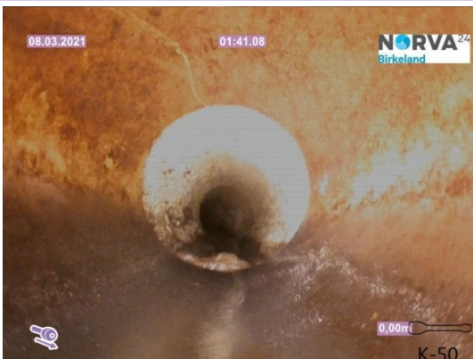
Spillvann_Septiktank_Påkobling hovedledning_20210308_110339.jpg
