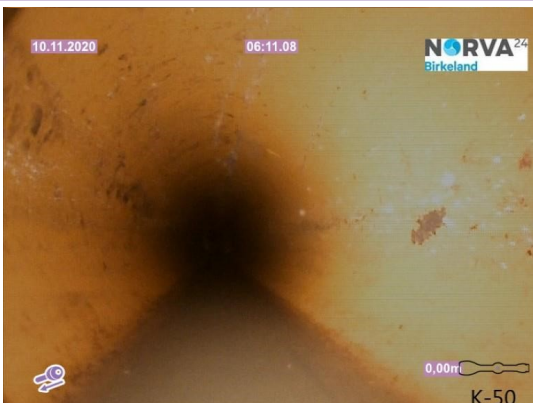
Spillvann_13-154 Årabrotvegn 19_Rør i grøft_20201110_093658.jpg
