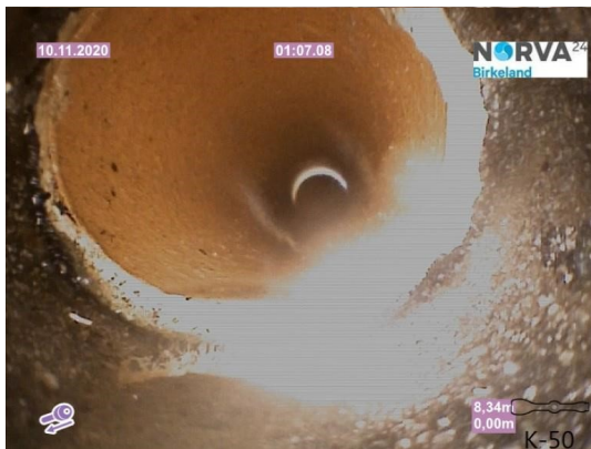
Spillvann_13-154 Årabrotvegn 19_Rør i grøft_20201110_094330.jpg
