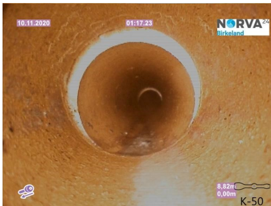
Spillvann_13-154 Årabrotvegn 19_Rør i grøft_20201110_094345.jpg
