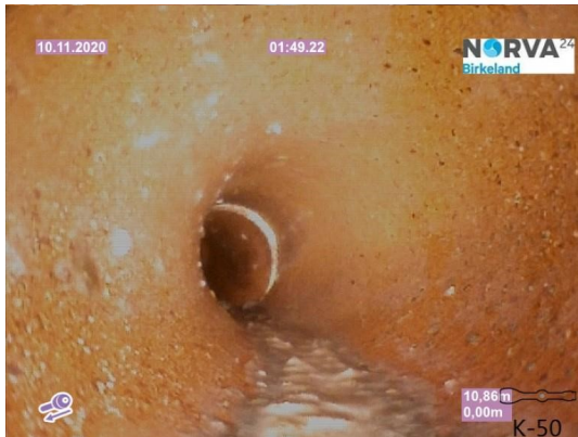
Spillvann_13-154 Årabrotvegn 19_Rør i grøft_20201110_094445.jpg
