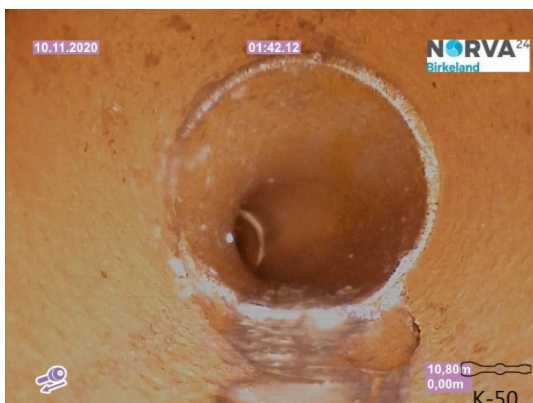
Spillvann_13-154 Årabrotvegn 19_Rør i grøft_20201110_094419.jpg
