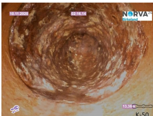
Spillvann_13-154 Årabrotvegn 19_Rør i grøft_20201110_094529.jpg
