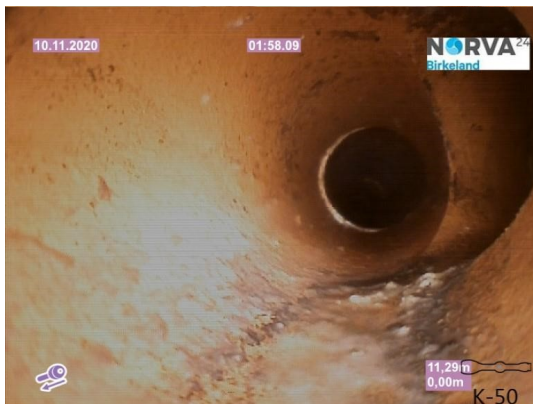
Spillvann_13-154 Årabrotvegn 19_Rør i grøft_20201110_094501.jpg
